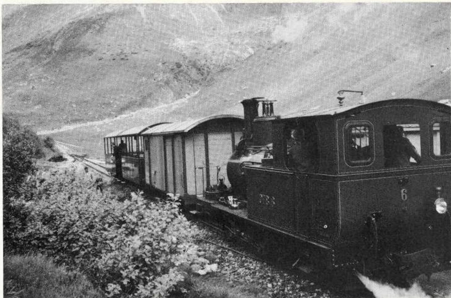
Endstation Tiefenbach. Links wird am neuen Geleise gearbeitet.
