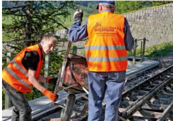
oben Schottereinbau mit dem Bericht-Verfasser
