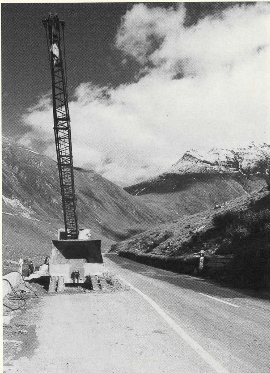
Bei Muttbach, wo dereinst Strasse und Schiene niveaugleich verlaufen werden, hat der Kanton Wallis im Spätherbst 1995 mit dem Bau der talseitigen Mauer begonnen.
