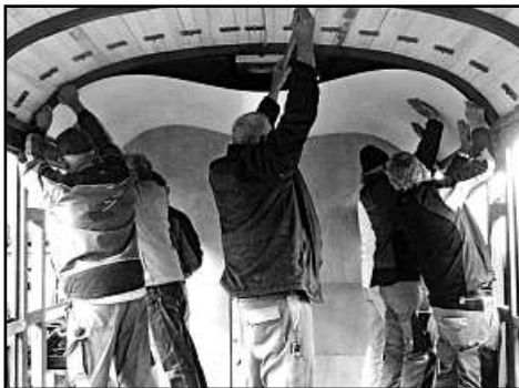
Einsetzen der Dachhimmelplatten mit vereinten Kräften
