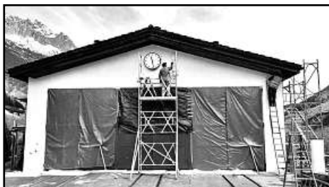
Die Lokremise mit den abgedeckten Toren und dem Rollgerüst. (jw)
