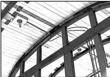
Die Leitungen müssen vor der Montage der Verkleidungen verlegt werden.
