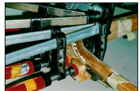
Instandsetzung der Fensterrahmen
