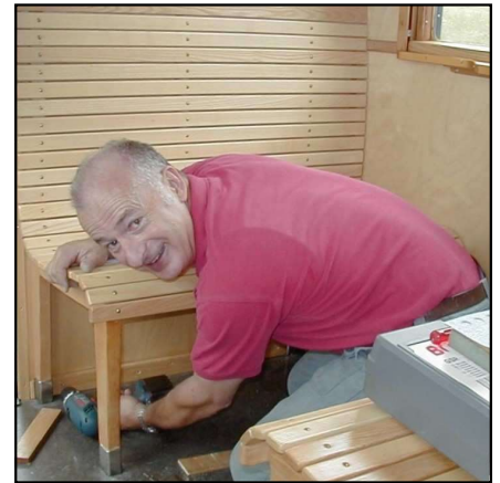
Schlussmontage der Bodenleiste unter der neuen Sitzbank
