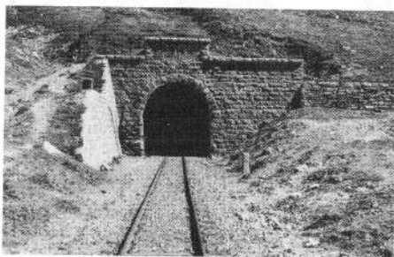
Abb. 18 Tunnelportal Scheiteltunnel, Seite Wallis A.J. Bonthuis, 1985
