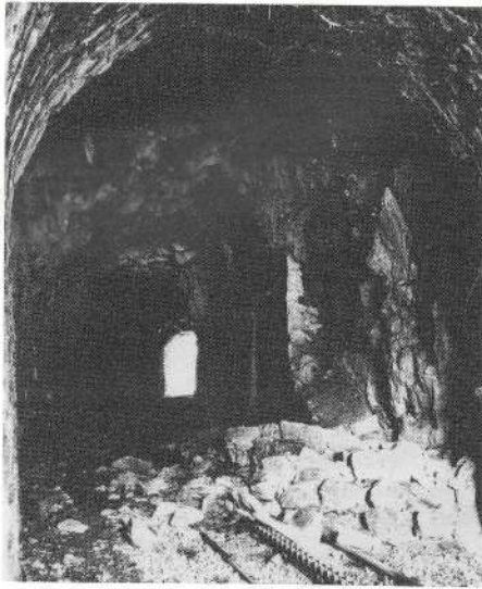
Abb. 22 Tunnel Senntum II R. Schorno, 1986
