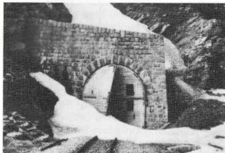
Abb. 17 Tunnelportal Scheiteltunnel, Seite Uri Archiv DFB 412/24 bhs
