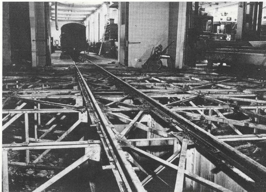
Die abgedeckte Drehscheibe vor dem Depot Pontresina
