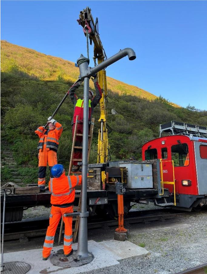
Mit dem Kranwagen «Bruno» montiert das Auswinterteam den Wasserkran der Station Tiefenbach.
