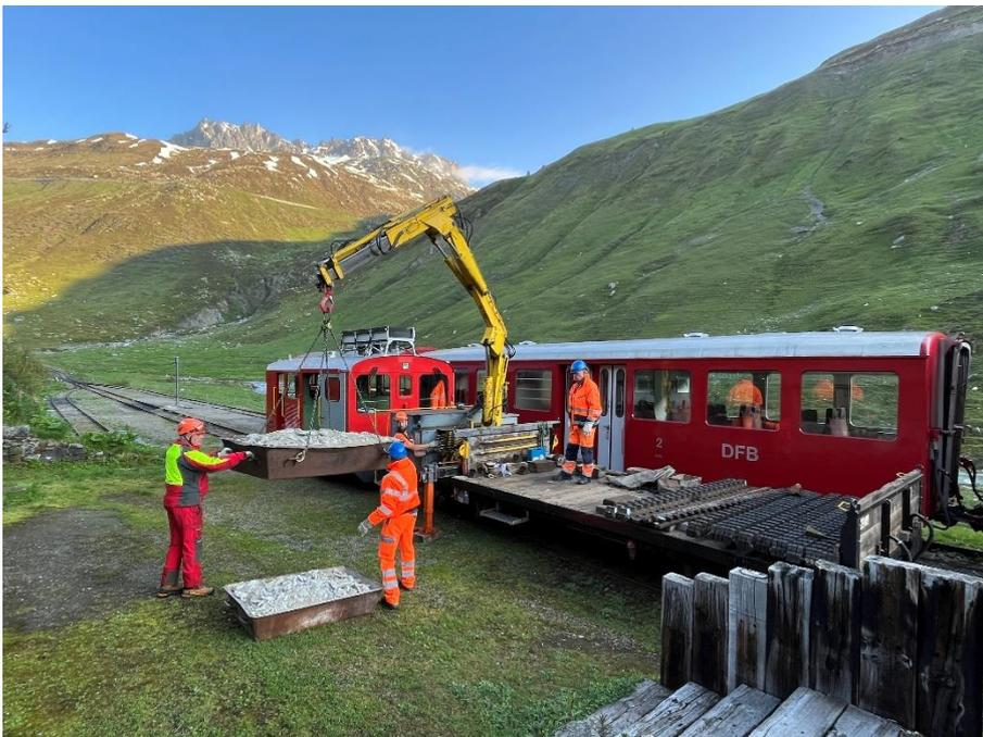
Nach der Montage des Wasserkran wird der am Vortag ausgespitzte Aushub des Wasserreservoirs profilfrei deponiert.
