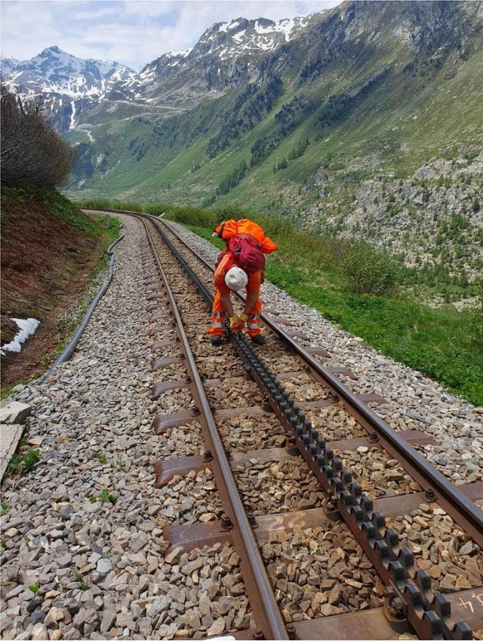
Werner Spahni und Bruno Zimmermann erfassen alle knapp 12'000 Zahnstangensattel zwischen Muttbach und Oberwald. Mit Schraubenzieher und Stahlbürste muss zuerst der Kopf des Sattels gereinigt werden. Anschliessend kann der Satteltyp abgelesen und dokumentiert werden.
