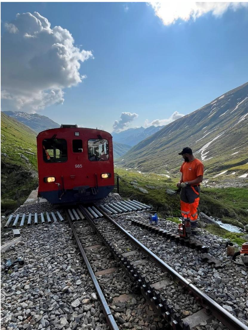
Martin Wieland bereitet das Bohren der Schraubenlöcher der letzten Zahnstange bei der Sidelenbachbrücke vor.
