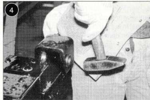
Erste Connex-Lagerbuchse eingesetzt. Links davon vorbereitete Bohrung.
