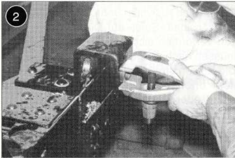
Einsetzen der neuen federnden Connex-Lagerbuchsen mittels Spannzange.
