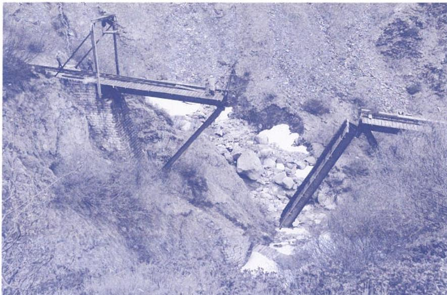
Der Mittelteil, welcher an der talseitigen Stütze schwenkbar gelagert ist, wird angehoben.
