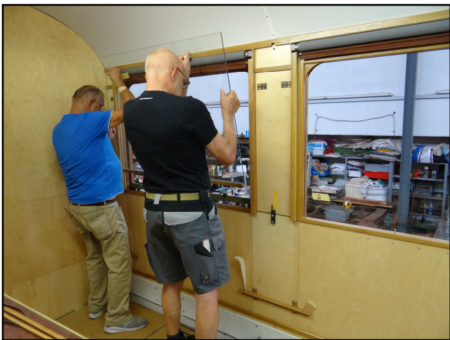
Einsetzen der Fenster nachdem die Gläser vorher mit Silicon in der Tragschiene fixiert wurden
