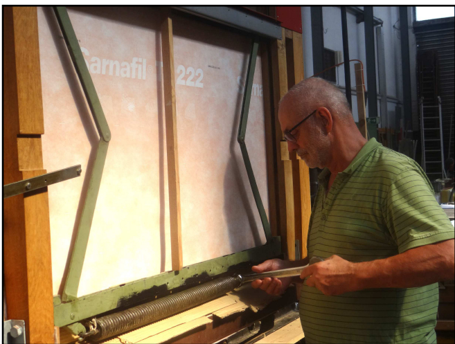
Justieren der Fensterscheren für einen leichten Lauf der Fenster
