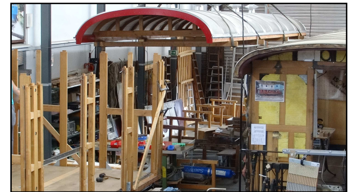
Aufsetzen des Daches auf das tragende Gerippe als vorgefertigte Einheit
