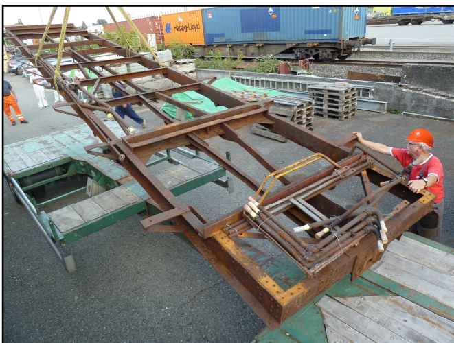
Aufladen des Chassis für den Transport zum Sandstrahlen (September 2014)
