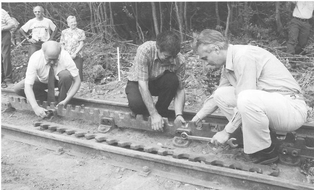
Thomas Burgener und Emil Kälin verschrauben, assistiert von Bauchef Walter Willi die erste Zahnstange. Boulonnage du premier rail-crémaillère par Thomas Burgener et Emil Kälin avec l'assistance du chef construction Walter Willi.
