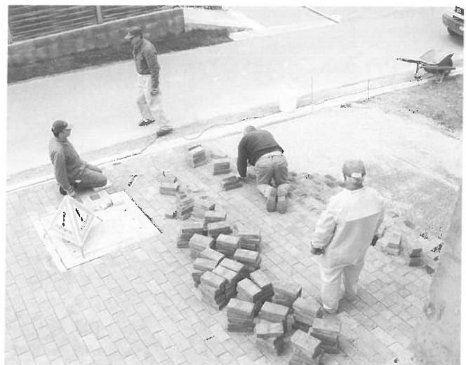
Gruppe beim Verlegen von Verbundsteinen. Groupe lors de la pose de plots de ciment.
