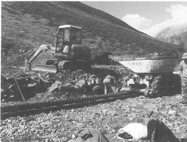
Bauarbeiten auf der Strecke – Travaux sur la ligne.
