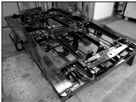
Blick in das Gewirr der Bremsstangen und -hebel in einem Drehgestell
