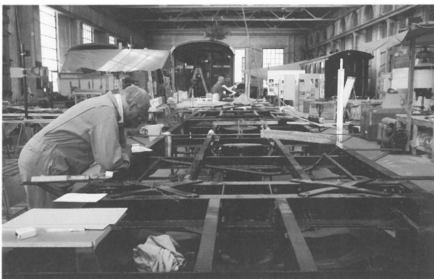
Der Blick über das Wagenchassis hinweg vermittelt zugleich eine Hallen-Übersicht. Le châssis de l'ancien B 2222 du BVZ dans la halle de l'atelier d'Aarau.
