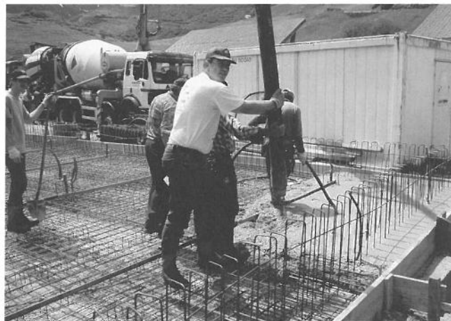
Betonierungsarbeiten für das neue Stationsgebäude / Beton storten voor het nieuwe stationsgebouw. (Foto: Paul Olijslagers) Travaux de bétonnage pour la nouvelle gare.
