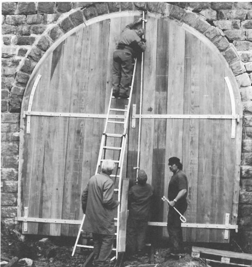
Das neue Tunneltor ist angeschlagen. (Foto: Fredo Stolz) Tunnel hélicoïdal : montage du nouveau portail.
