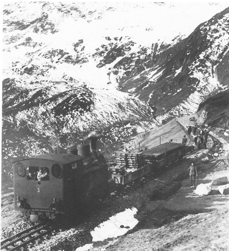
Train de chantier sur le versant est du col de l'Oberalp, fin 1915. (coll. H. Dellsperger) Bauzug, Ostseite Oberalppass im Herbst 1915 (Sig. H. Dellsperger)
