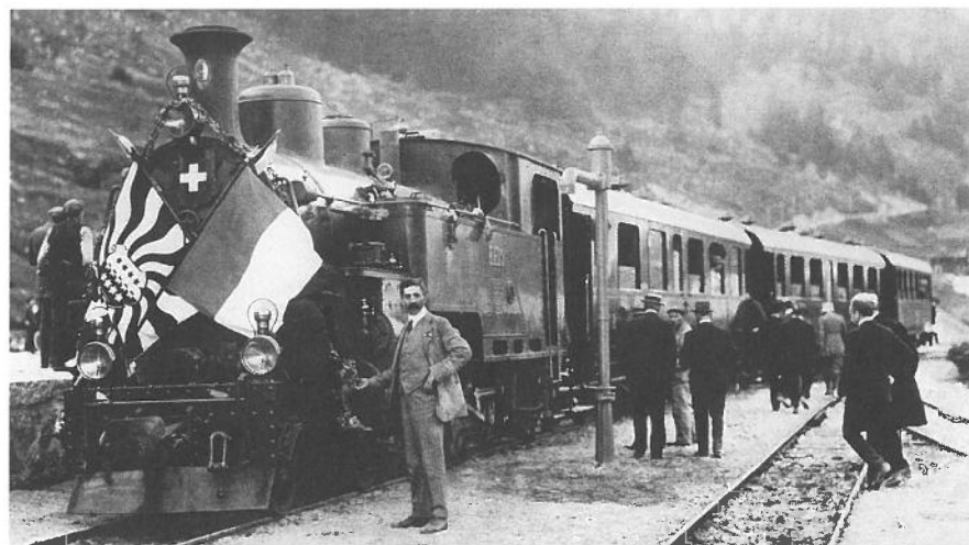
Inauguration en juin 1914 du tronçon Brigue-Gletsch, loc no. 9 en gare d'Oberwald (coll. H. Dellsperger)
