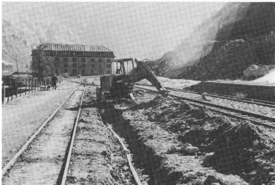
Ambiance matinale dominicale sur l'aire de la gare de Gletsch. La tranchée pour le câble électrique du dépôt.
