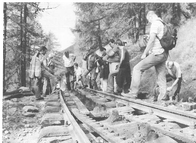
Gleisbaustelle unterhalb Realp Chantier de la voie
