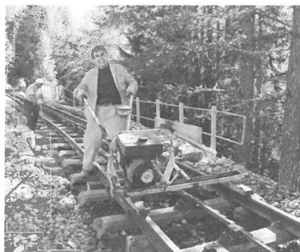
Willy Aufdermaur bei Gleisbauarbeiten beim «Lammenviadukt». Willy Aufdermaur à l'entretien de la voie sur le viaduc de Lammen.
