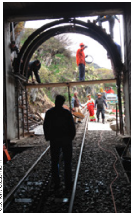
Montage des Leegerüstes / Montage du coffrage
