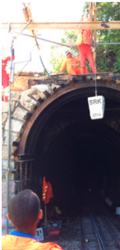
Der Gewölbekopfstein wird eingebaut/ Pose de la pierre de voûte
