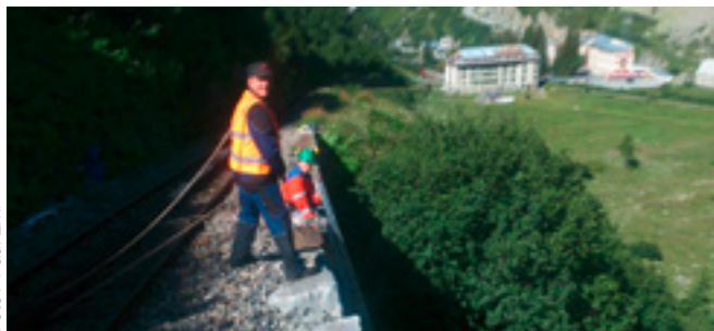
L'échelle ne repose sur rien, elle est attachée au rail et le collègue est encordé.
