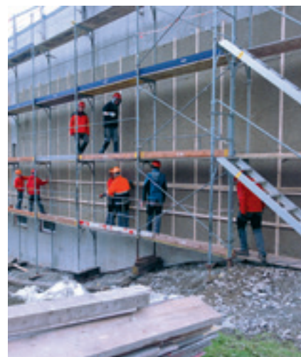
Rost- und Isolierarbeiten am neuen Depot / Travaux d'isolation au nouveau dépôt
