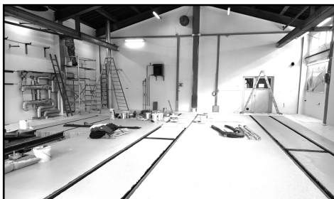
Der Hallenboden wurde abgedichtet und neu beschichtet (tb)
