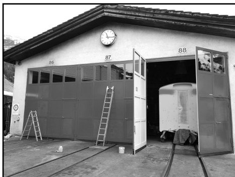
Die sanierte Lokremise mit den neu gestrichenen Toren (tb)
