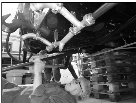
Das „Hirschgeweih“ wird eingebaut
