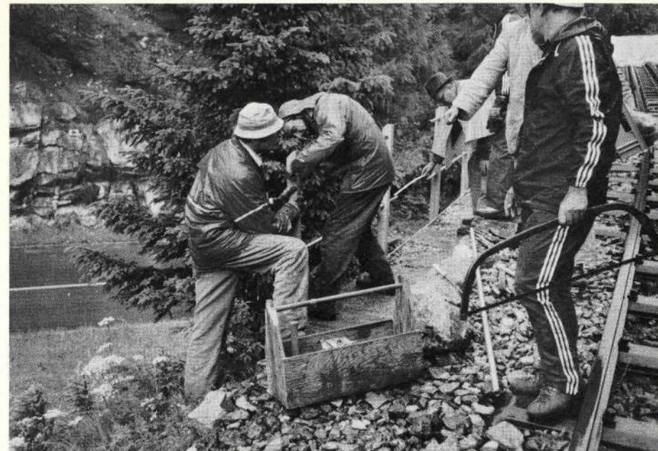
Mitglieder aus verschiedenen Sektionen stellen die Geländer der Lammenbrücke fertig. Des membres venus de différentes sections posent les garde-fous du pont de Lammen.
