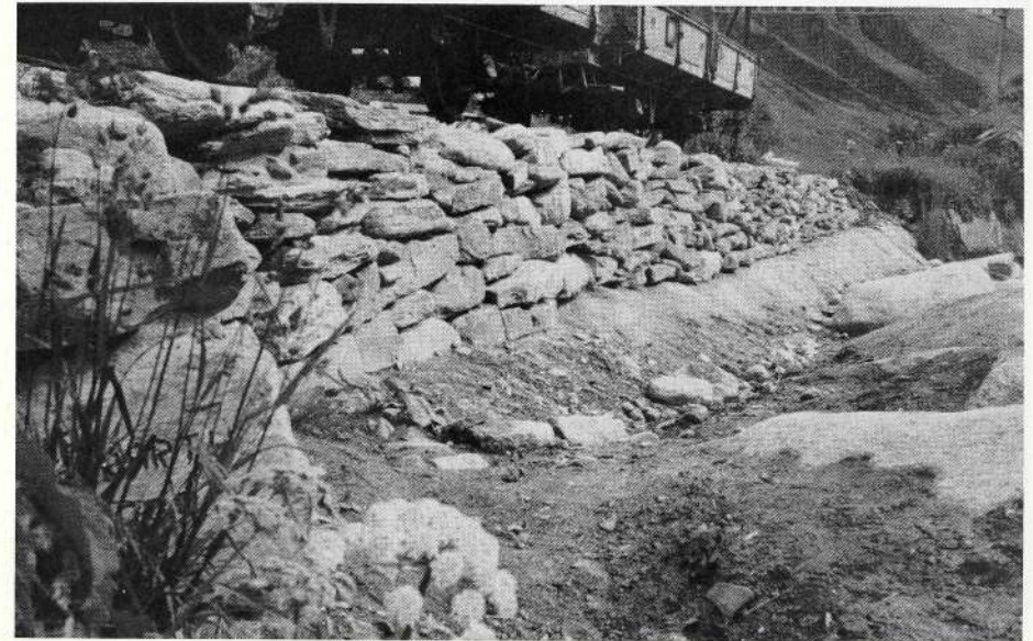
Schüler aus der Innerschweiz haben in einem Einsatz in Realp anlässlich einer Lagerwoche diese schöne Trockenmauer erstellt. Un groupe d'écoliers de Suisse centrale a bâti ce beau mur en pierres sèches lors d'un camp d'une semaine à Realp.
