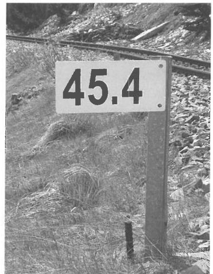
Fertig montierte Hektometer-Tafel. Borne terminée et installée.
