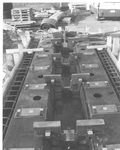
Detail zur armierten Zahnstange. (Foto: Bänz Bangerter) Détails de la crémaillère armée. (Photo: Bänz Bangerter)
