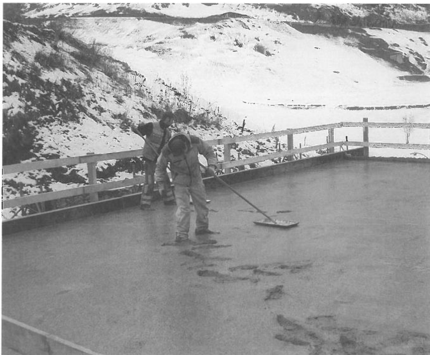
Abtlochung der Deckenoberfläche. Talochage du toit.
