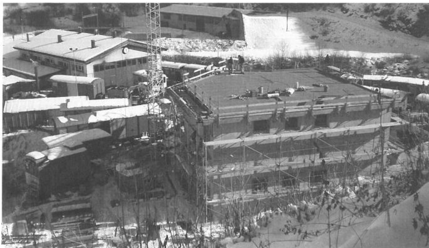
Die provisorische Dachhaut wird verlegt. Im Hintergrund Einfahrt Basistunnel Furka. Pose de la couverture provisoire. Au fond, portail du tunnel de base de la Furka.
