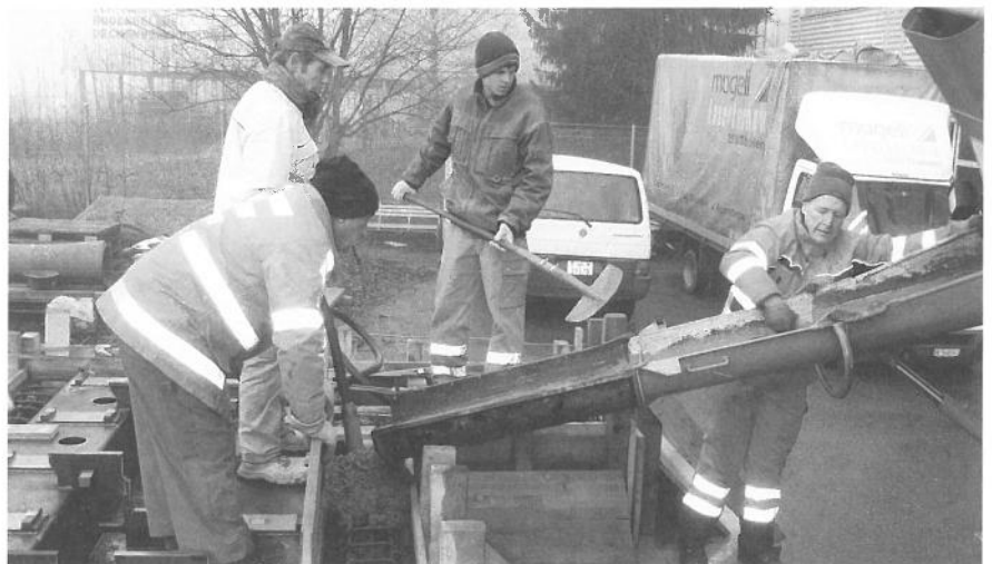
Beton wird eingefüllt. (Foto: Bänz Bangerter) Coulage du béton. (Photo: Bänz Bangerter)
