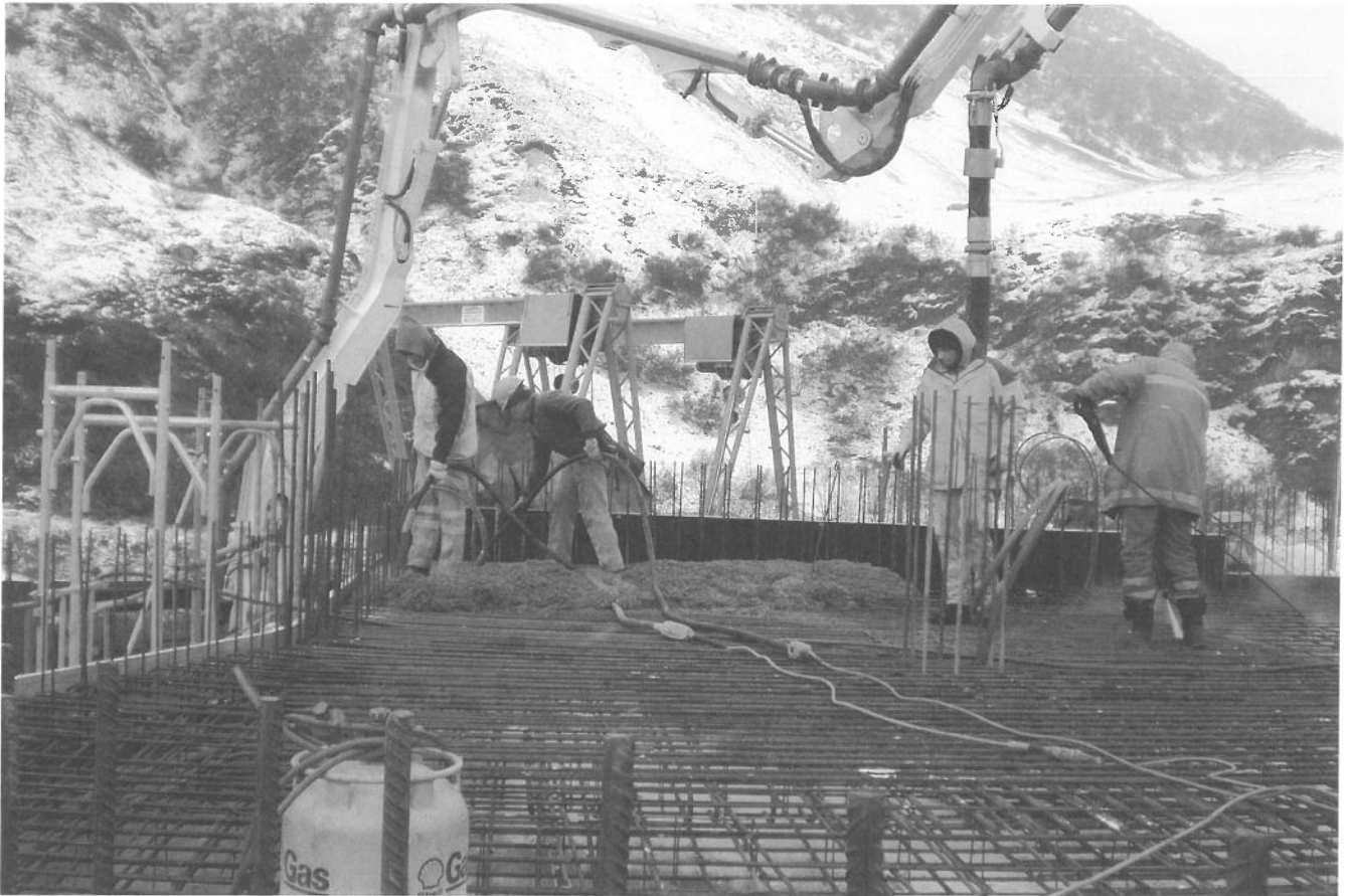
Der Beton wird auf die Decke gepumpt. Pompage du béton sur le toit.
