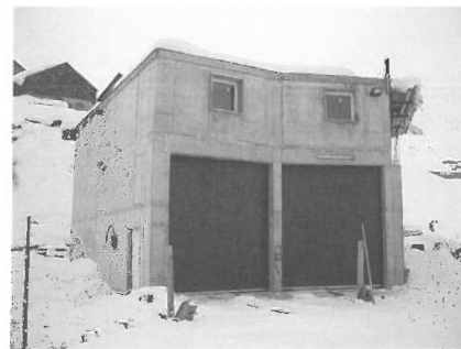
Bereit für den Bezug Rolltore und Fenster sind verlegt. Prêt pour l'emménagement. Portes et fenêtres sont installées.
