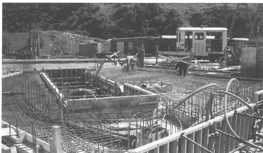
Ob der Elektriker an alles gedacht hat? L'électricien n'a-t-il rien oublié?
