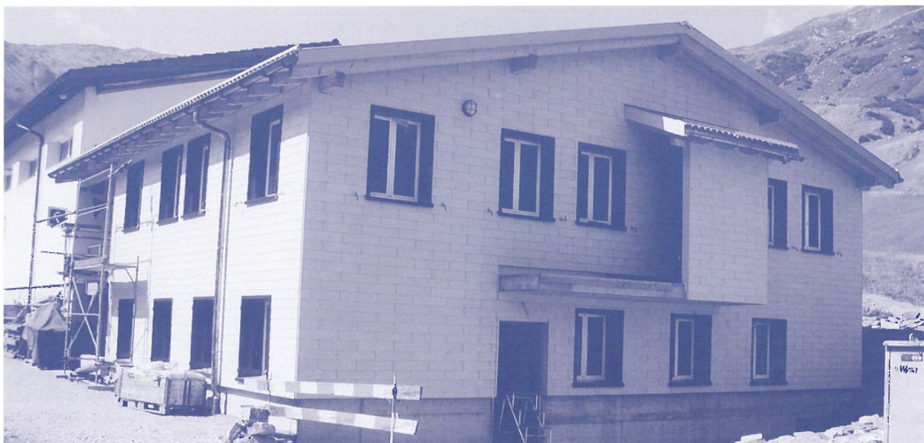
Fertiggestellte Fassade Kantine (September 03)
