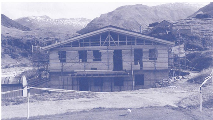
Rohbau Kantinentrakt (Juli 03)
