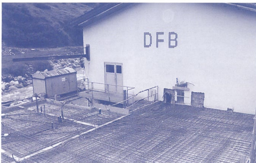
Betonarmierung Decke Untergeschoss Kantine (Juni 03)
