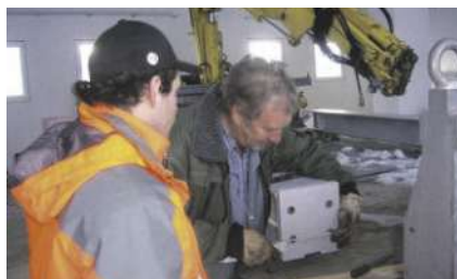
Hansjörg Leibundgut bei der Bearbeitung der Kranbahn für die Halle Gleis 82/83 / Hansjörg Leibundgut lors du façonnage du chemin de roulement de la grue de la halle voie 82/83
