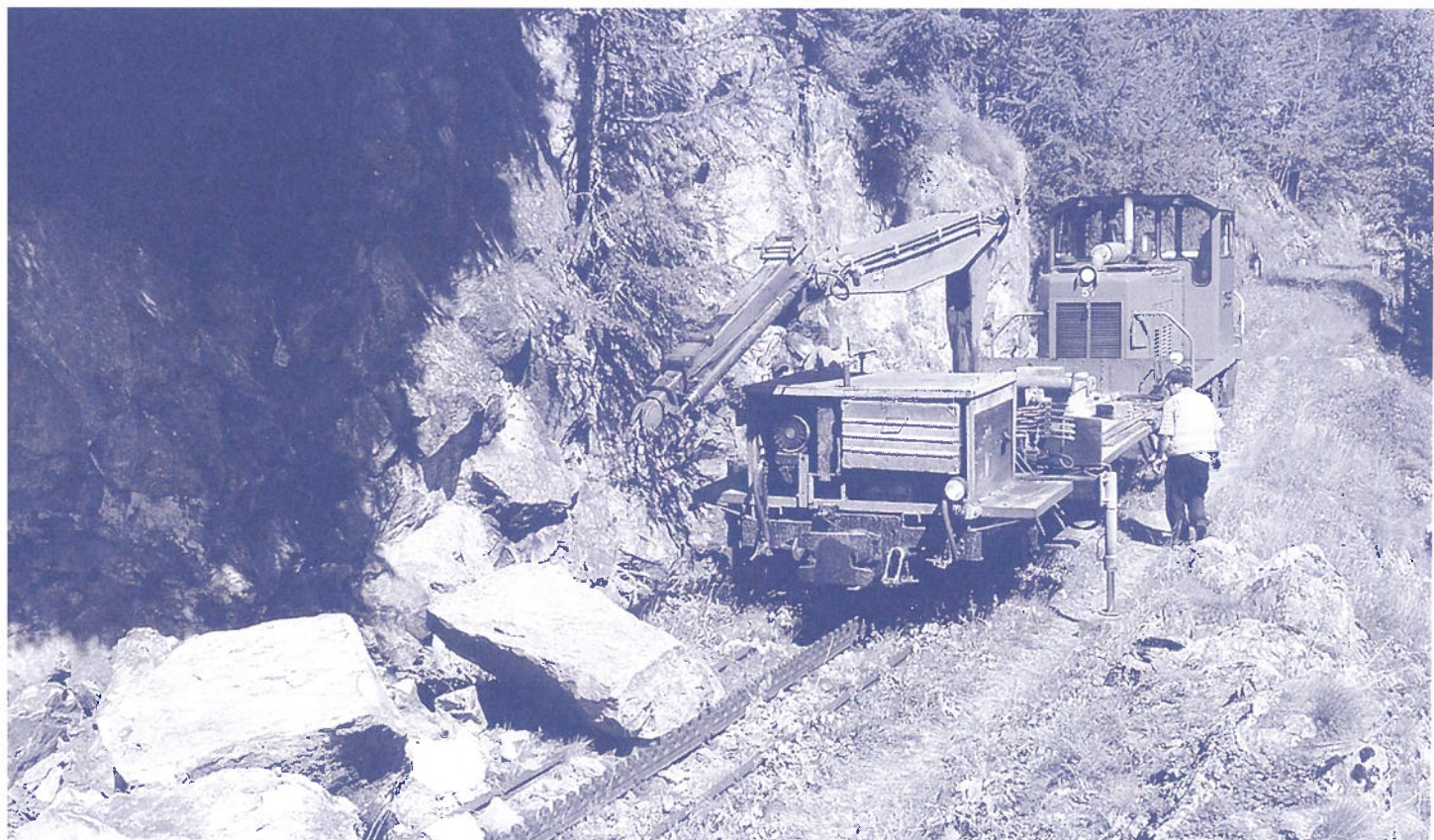
Felsbrocken und Steine werden vom Trasse geräumt.
