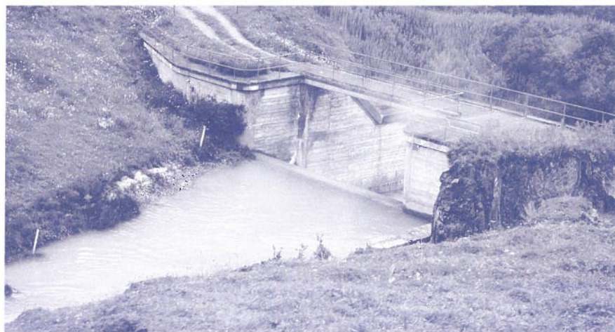
Brücke und Einlaufbauwerk an der Furkareuss. Von hier führt ein Stollen zum Göschenalpsee.
