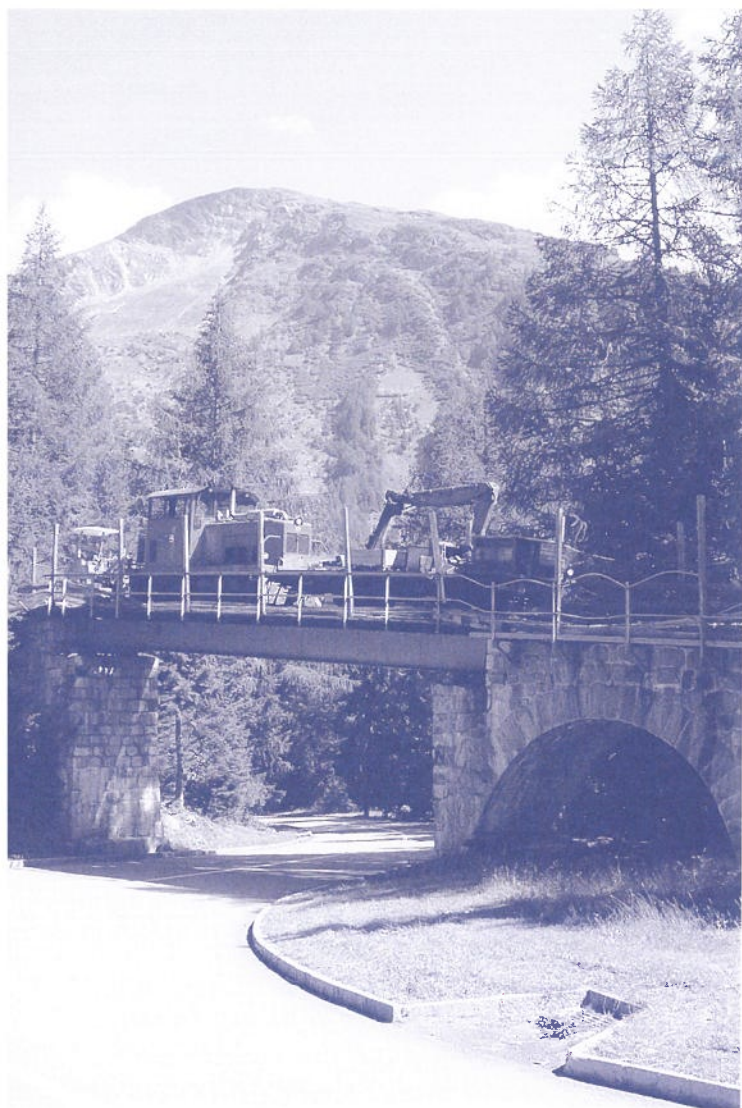
Bauzug auf dem Lammenviadukt.
