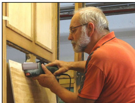
Sorgfältige Einpassung der Wandplatten aus Birkensperrholz
