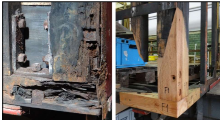
Eine Wagenecke vor und nach der Reparatur
