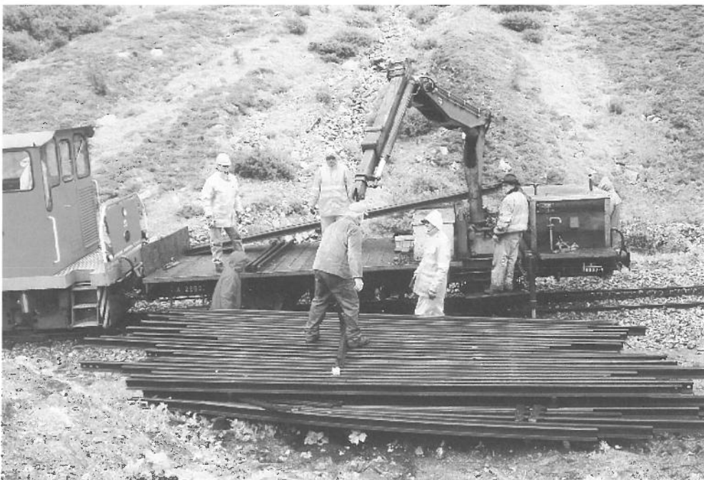
Schienenverlad – Chargement de rails.
