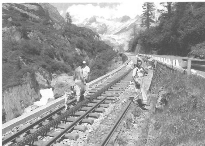
Gleisbauarbeiten Construction de la voie
