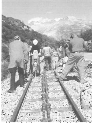
Gleisstopfarbeiten. Bourrage de la voie.
