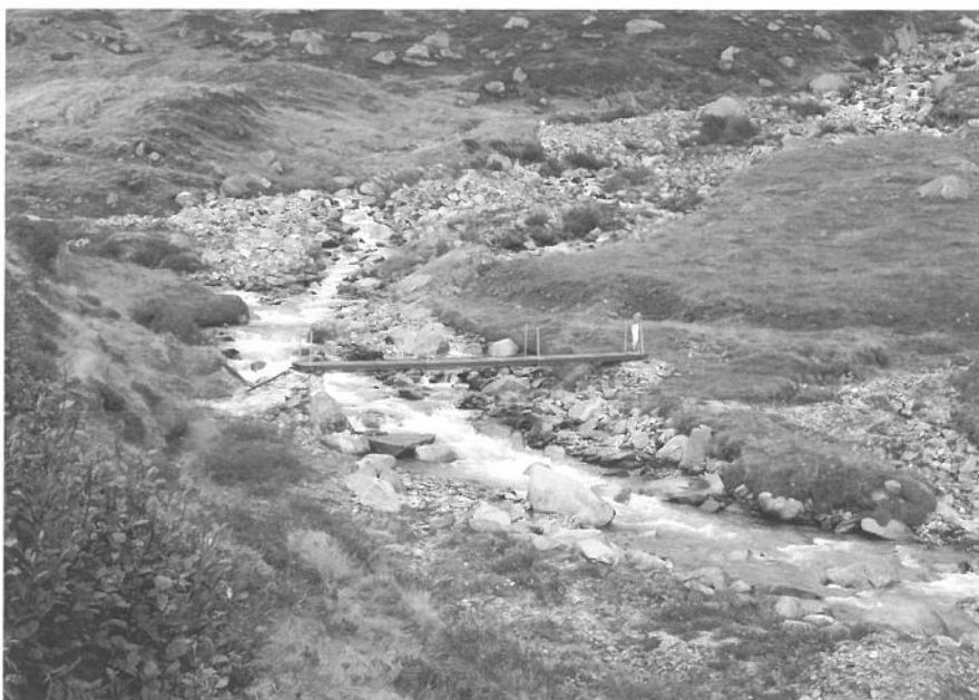
Die Brücke über die Furkareuss bei der Haltestelle Tiefenbach. Le pont sur la Furkareuss près de la halte de Tiefenbach.
