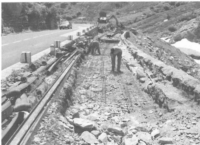
Trasse-Erneuerung unterhalb Gletsch Renouvellement du tracé en dessous de Gletsch
