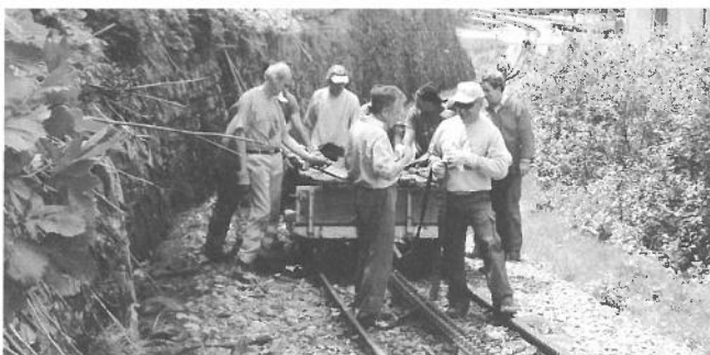
Baugruppe auf der Strecke. – Equipe de travail sur la voie.
