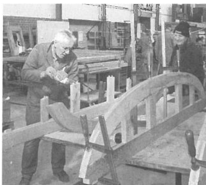
Herstellung der Dachelemente für die Wagen-Stirnseiten / Production d'éléments de toits pour les parties frontales des wagons
