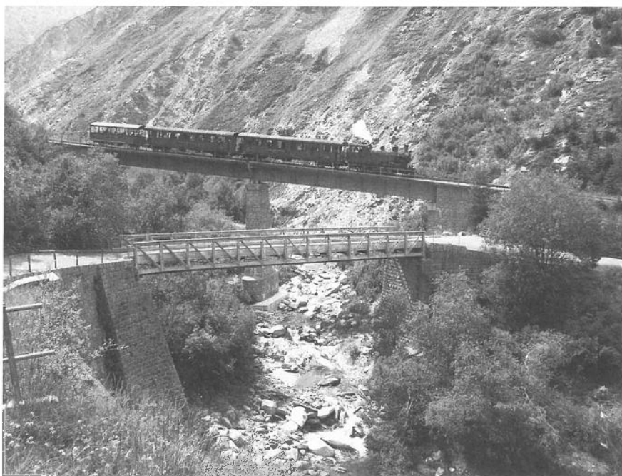
Wilerbrücke mit Zug der Dampfbahn Furka-Bergstrecke (HG 3/4 Nr. 1), 2007; im Vordergrund die Brücke der Militärstrasse ins Witenwasserental / Pont de Wiler avec convoi du Train à vapeur de la Ligne sommitale de la Furka (HG 3/4 no. 1), 2007; au premier plan, le pont de la route militaire en direction du Witenwasserental
