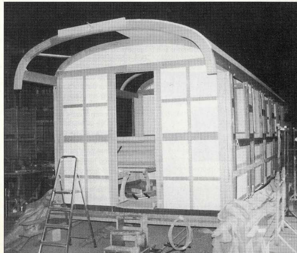
Der Wagenkasten C204, das Wagen-Dach ist hier teilweise montiert Foto: P. Grünig
