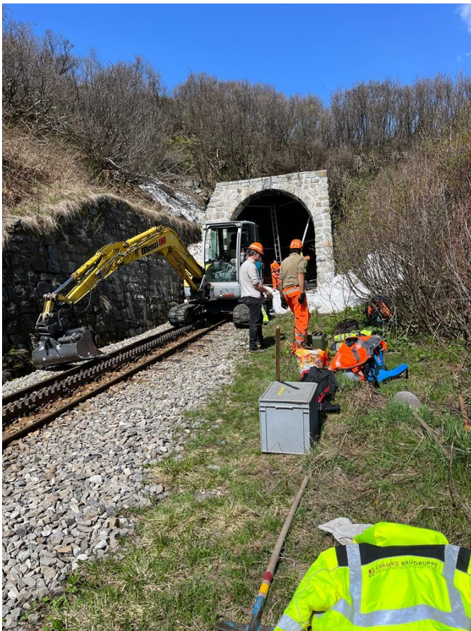
Alexander Briner räumt mit dem Menzi Bagger den Rest der Lawine am talseitigen Portal des Tunnels 1 weg. Bild: Achim Schüler.
