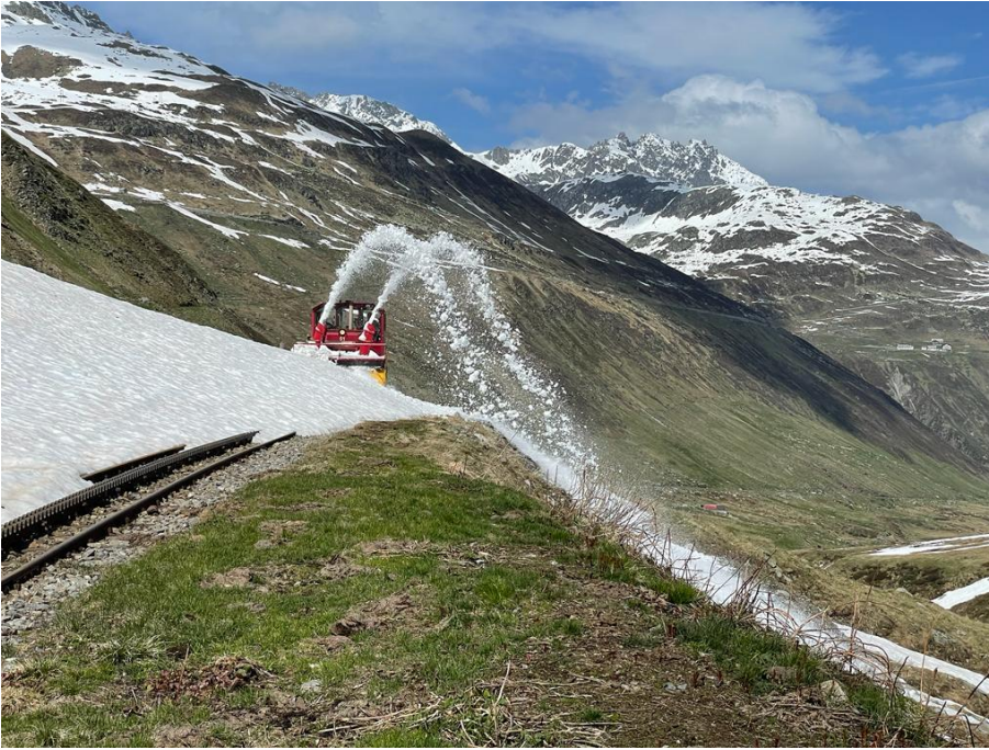
Die HGM 51 mit Anbaufräse kurz vor der Station Furka.
