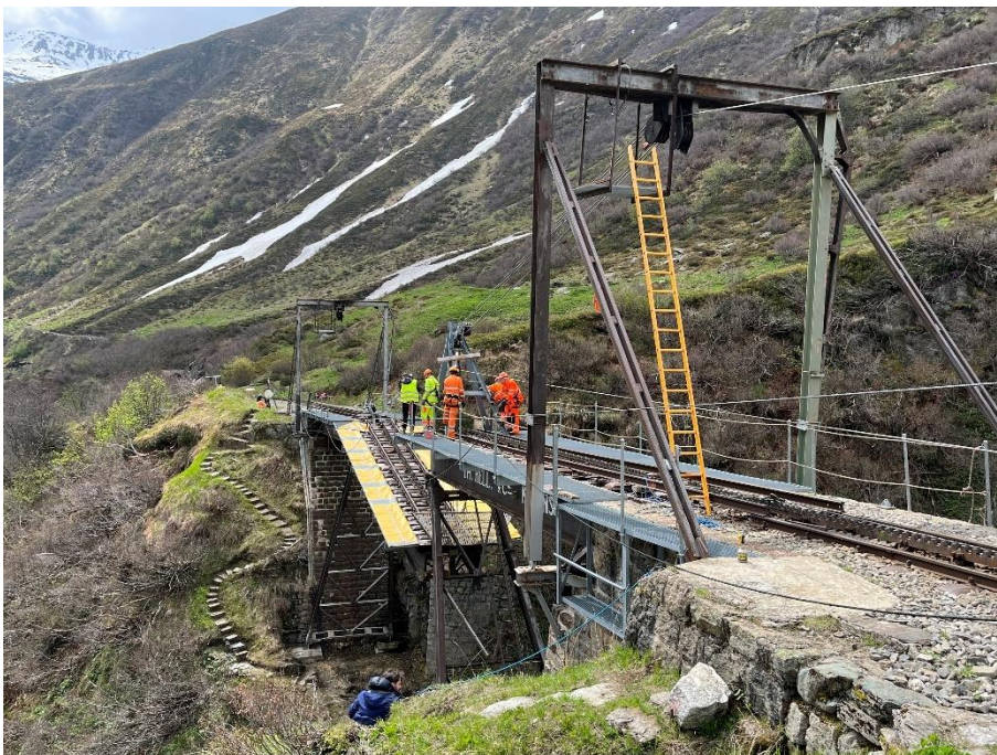
Langsam wird das mittlere Brückenelement in die Sommerstellung angehoben. Bild: Patrick Smit.
