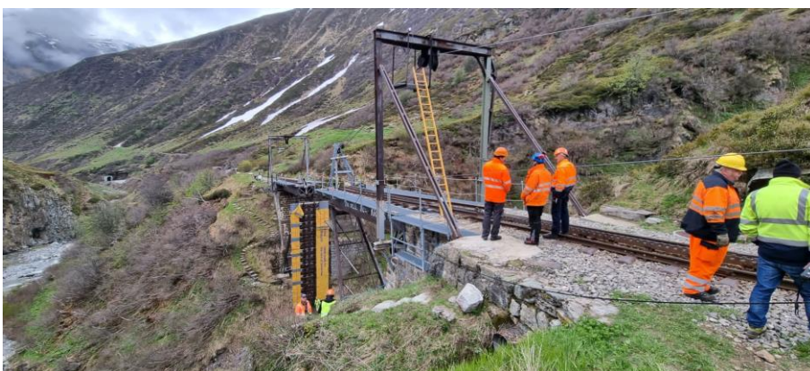
Das bergseitige Brückenelement ist in der Sommerstellung. Nun wird der Flaschenzug für das Hochziehen des mittleren Brückenelements vorbereitet. Bild: Hans-Ludwig Schneider.
