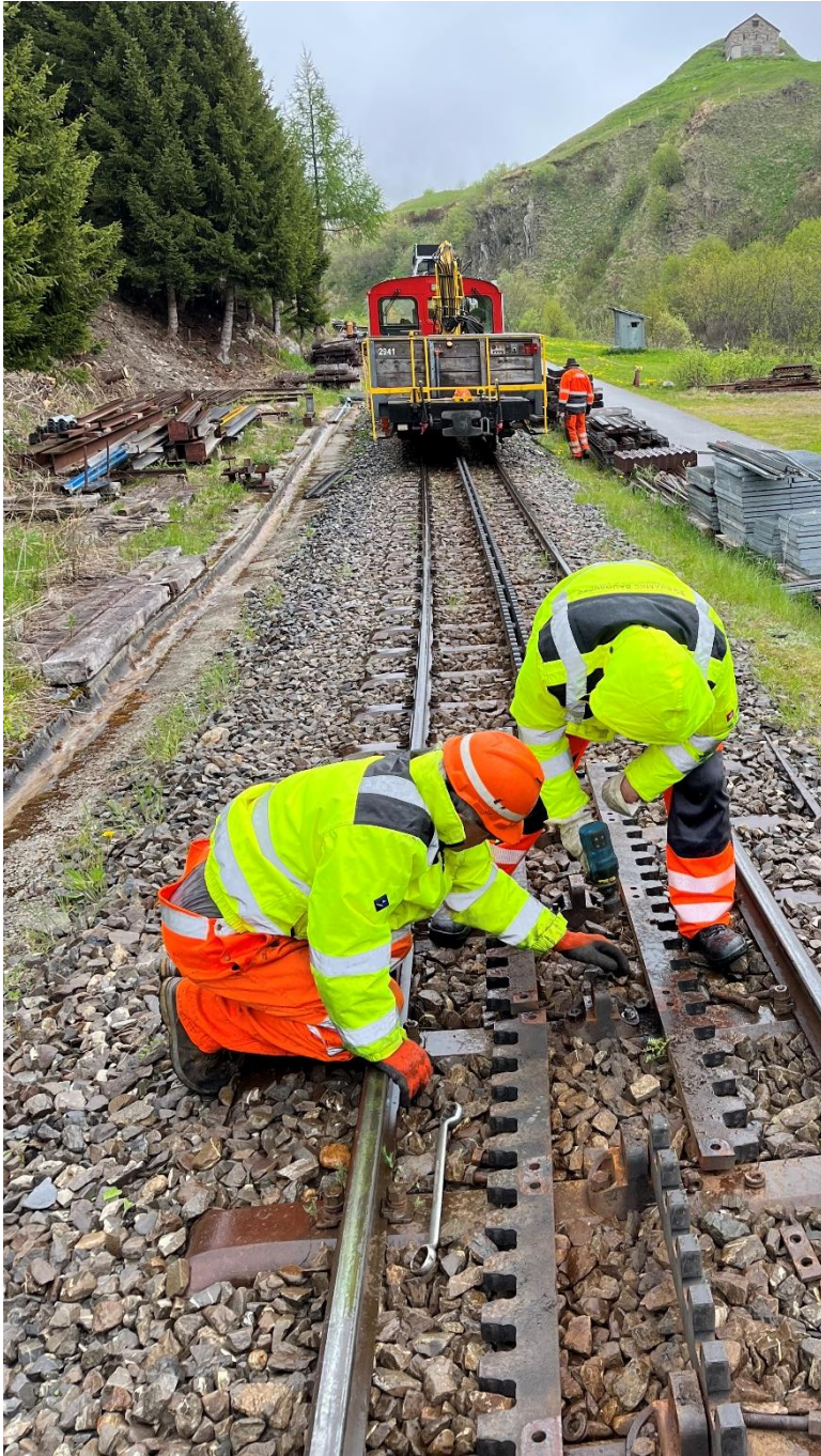
Ed Groenendijk und Achim Schüler beim Austauschen eines Zahnstangensattels. Bild: Patrick Smit.
