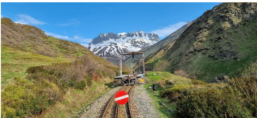
Die Fahrt mit der Tmh 985 und dem Tiefgänger endet unterhalb der Steffenbachbrücke.
