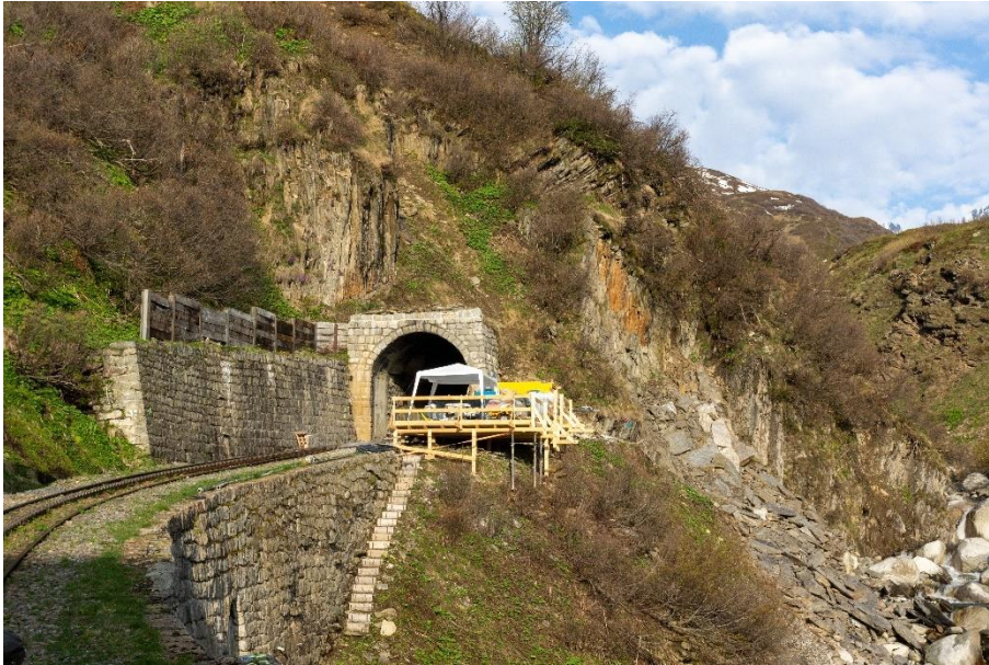
Der Bauplatz beim talseitigen Portal des Tunnels 3.
