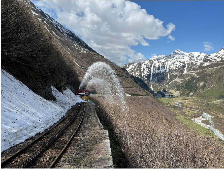
Schneeräumung oberhalb der Hilfsbrücke.
