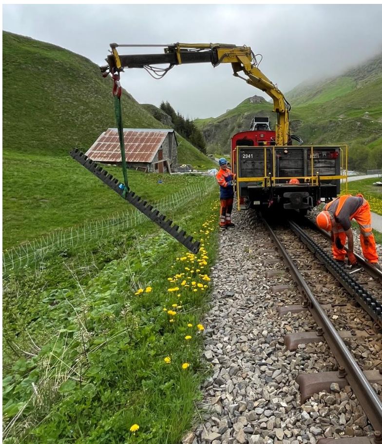
Während Ernst Demonti die neue Zahnstange ablädt, demontiert Ed Groenendijk die auszuwechselnde Zahnstange.
