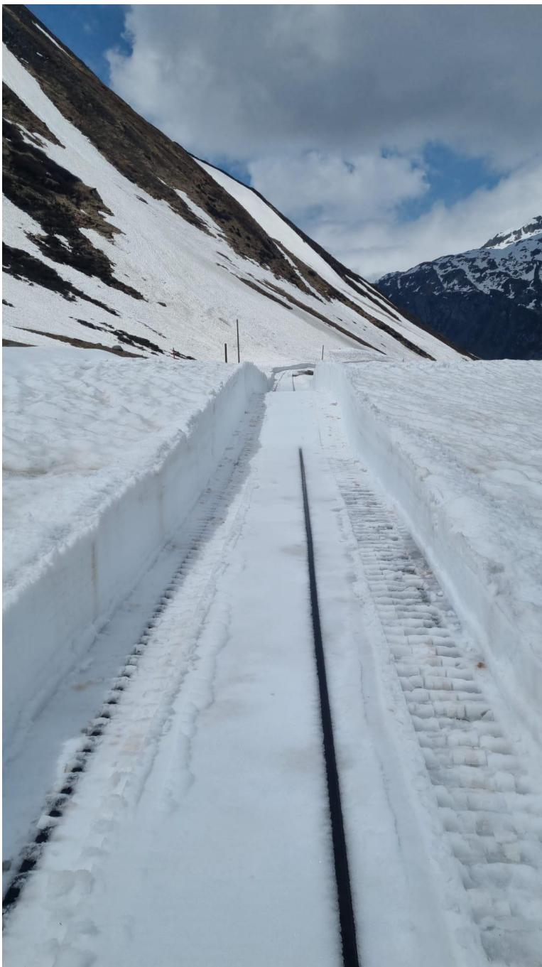
Das Gleis 1 der Station Muttbach-Belvédère ist mit der INTRAC Schneefräse geräumt. Bild: Stephan Stauber.
