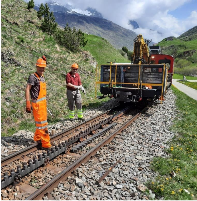
Ed Groenendijk und Alexander Briner beim Auswechseln einer Zahnstange zwischen der Zahnstangeneinfahrt Realp und Wilerbrücke.
