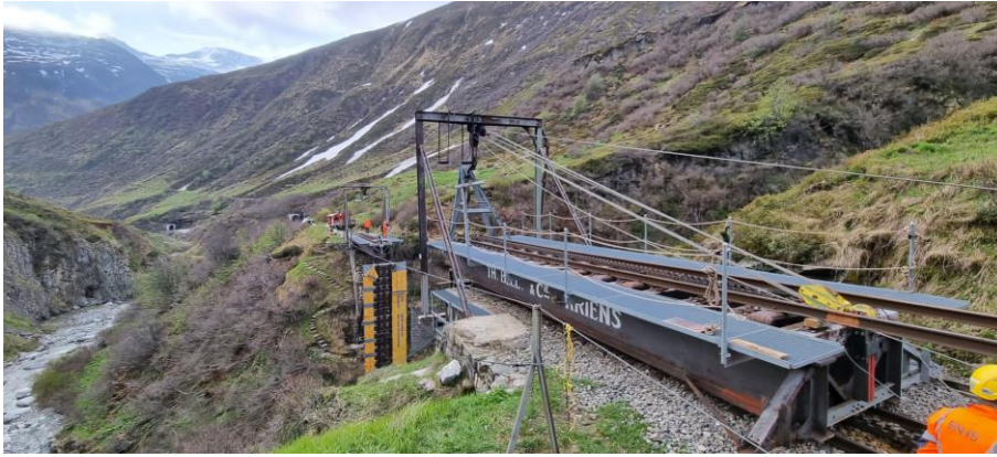
Die Flaschenzüge sind am bergseitigen Brückenelement angebracht. Bild: Hans-Ludwig Schneider.
