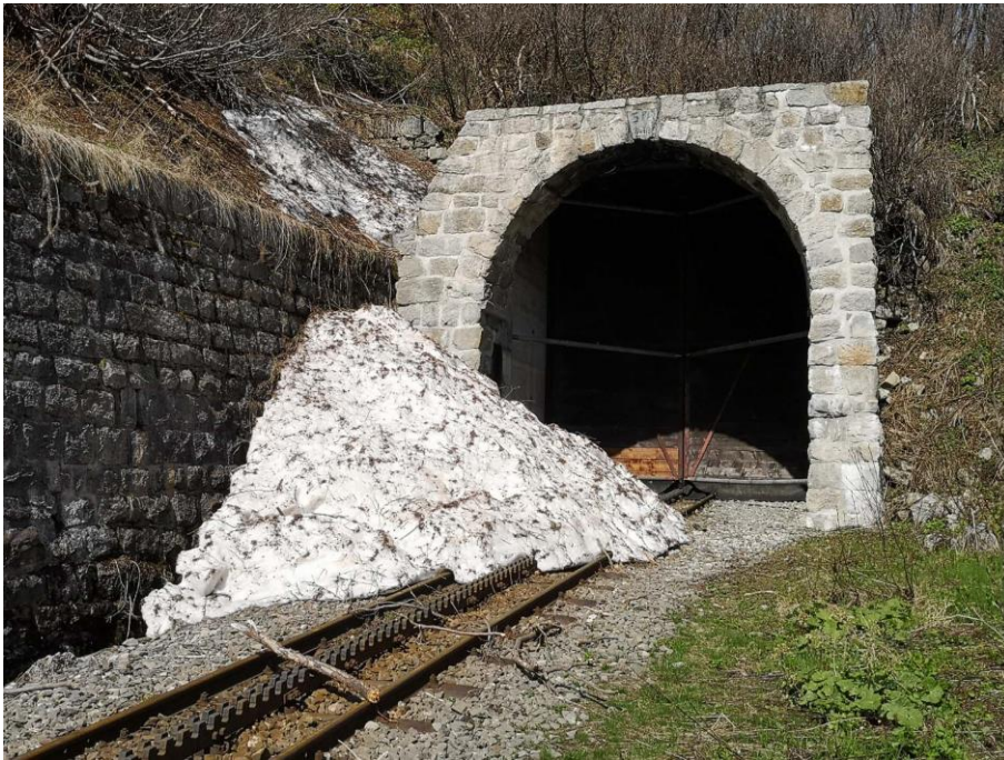
Der kümmerliche Rest der Lawine am talseitigen Portal des Tunnels 1. Bild: Urs Züllig.
