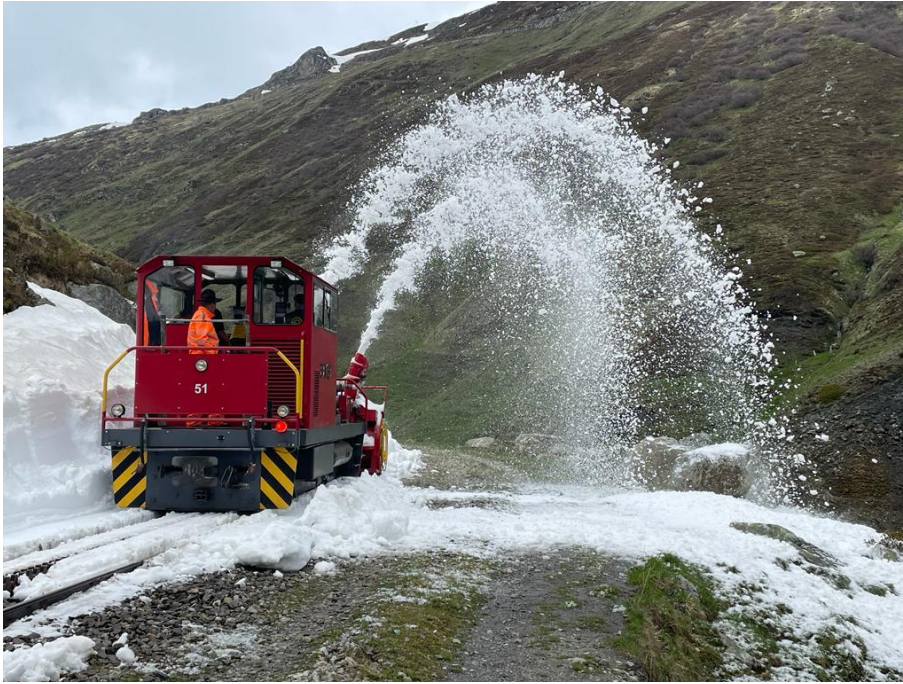
Die HGM 51 mit Anbaufräse kurz vor dem Steinstafelviadukt Bild: Thomas Holder.
