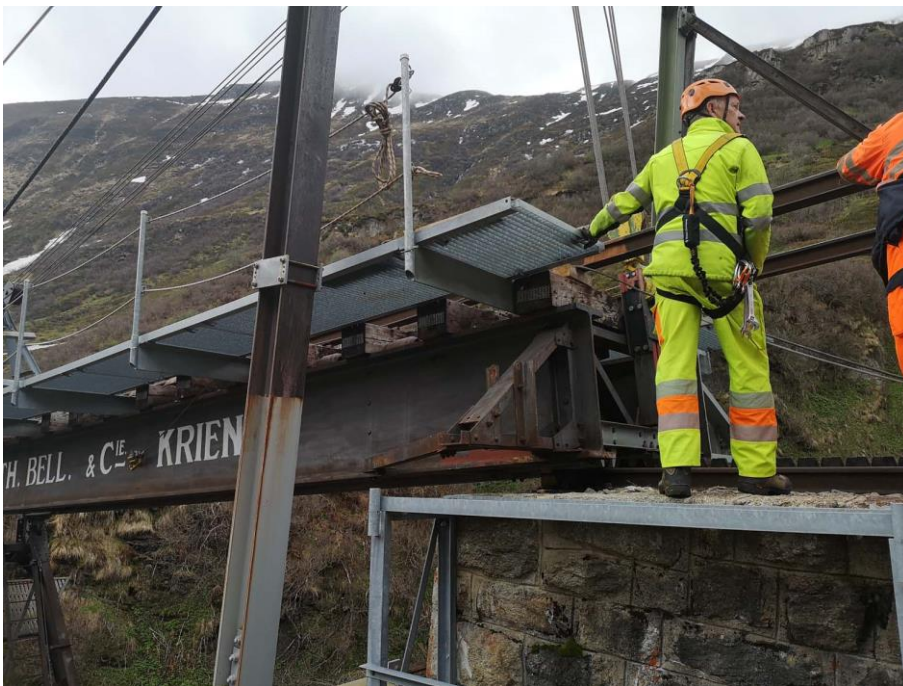
Christoph Spinnler überwacht den Vershub des bergseitigen Brückenelements in dessen Sommerstellung. Bild: Urs Müller.
