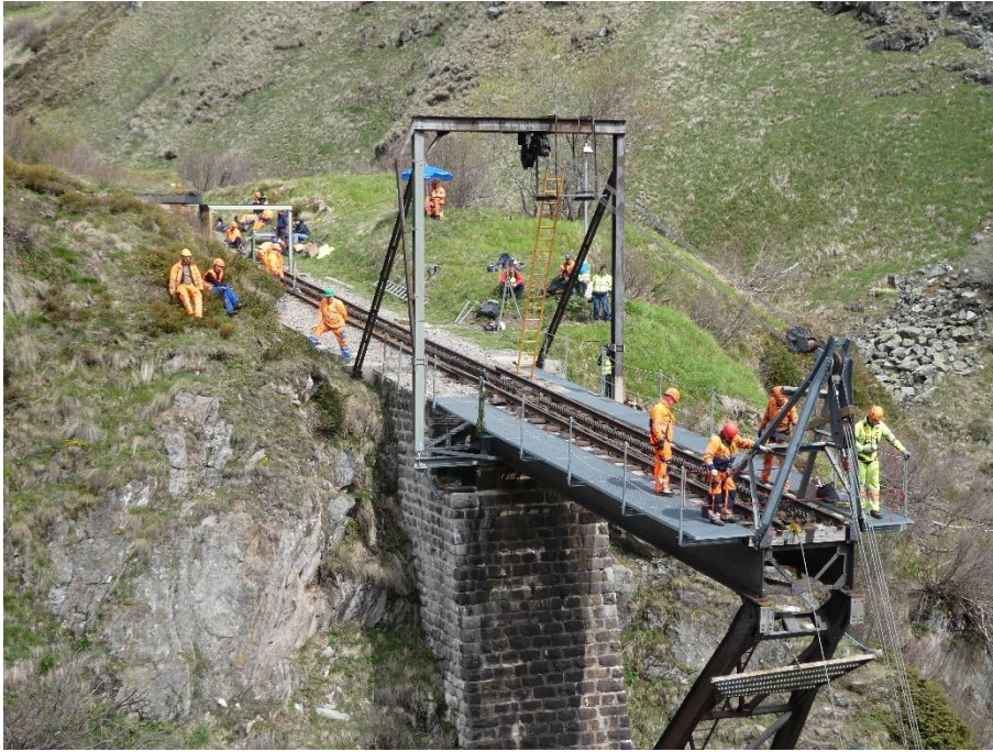
Das bergseitige Brückenelement in der Sommerstellung. Bild: Ruedi Tobler.
