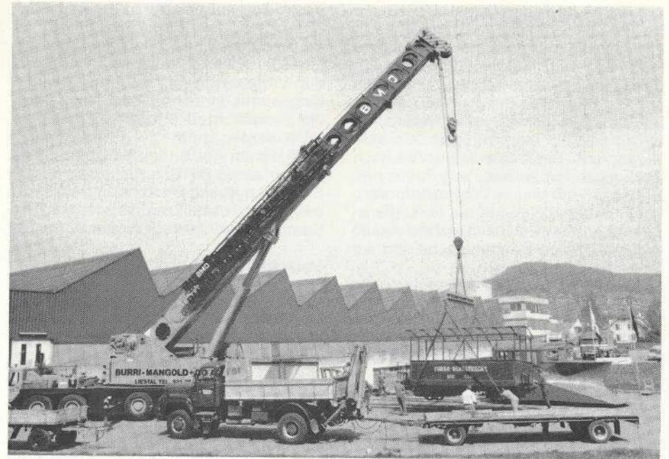
Ablad zur Ausführung diverser Fertigstellungsarbeiten (Burri-Mangold+Co AG hat uns unentgeltlich unterstützt)
