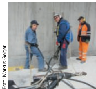
Abspitzen der alten Betondecke / Piquage de l'ancienne couverture en béton
