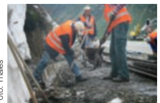
Froni bauen in Muttbach einen Entwässerungskanal ein / A Muttbach, des bénévoles installent un canal d'évacuation des eaux
