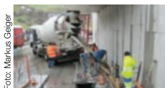
Einbringen des Betons für die Mauer / Coulage du béton pour la mur
