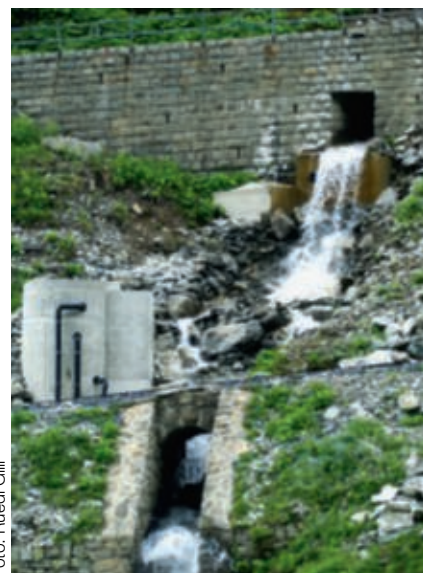
Wasserfassung II (Minarett) bei km 44.638 / Captage II (minaret) au PK 44.638
