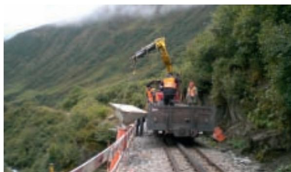
Knochenarbeit beim Unterbetonieren der Stützmauern
