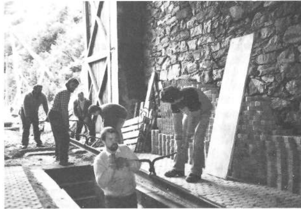
Einbau der Schienen bei der zweiten Grube im Lokschuppen Gletsch
