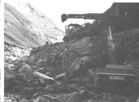
Wiederaufbau der beim Unwetter vom 25. August beschädigten Stützmauern unterhalb Tunnel III
