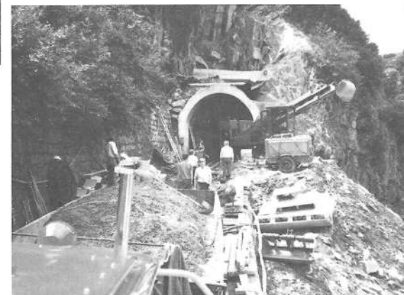
Die Baustelle am Tunnel III
