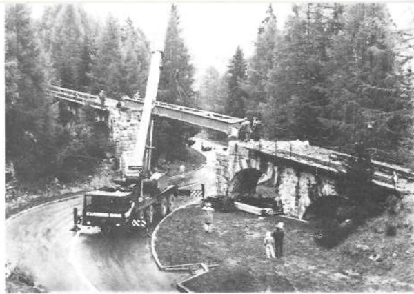
Einbau der Stahlkonstruktion beim Lammenviadukt am 20. Juni
