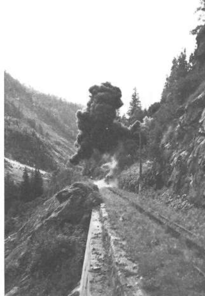
Felssprengung zwischen Oberwald und Gletsch
