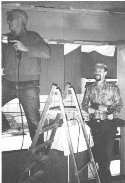
Ausbau des Wohntraktes im Lokschuppen, Täfern der Küche in Gletsch
