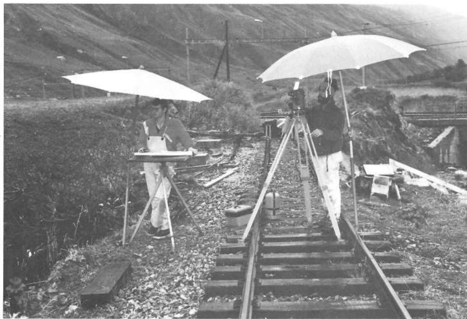
Vermessungsarbeiten im strömenden Regen, im rauen, unwegsamen Gelände der Furka-Bergstrecke; trotzdem wurde die Arbeit gerne getan.
