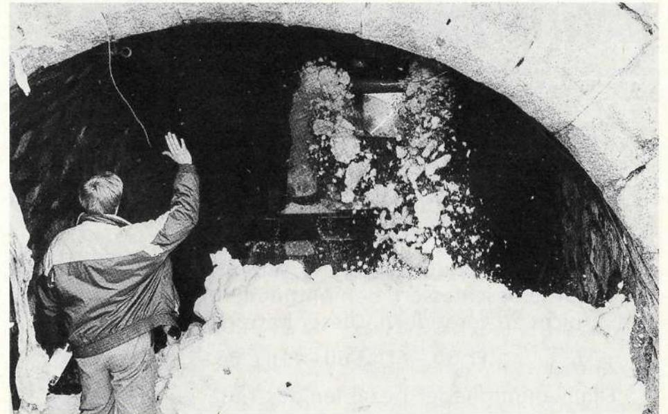
Die Schneefräse im Element, beim Beseitigen des Schnees aus dem Tunnel.
