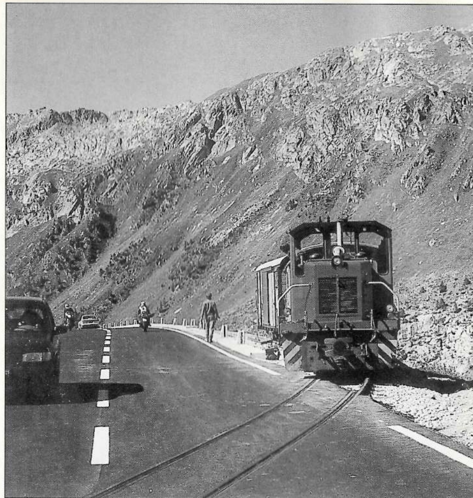
Es ist Tatsache geworden, beidseitig der Strasse sind Zahnstangeneinfahrten vorhanden, die den «Weg» in Richtung Gletsch ermöglichen. Der neue Strassenübergang Muttbach.
