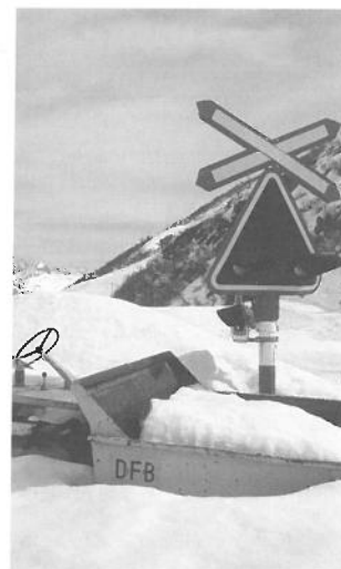
An diesem Übergang ruht der Verkehr auf Schiene und Strasse. Repos hivernal au passage à niveau.
