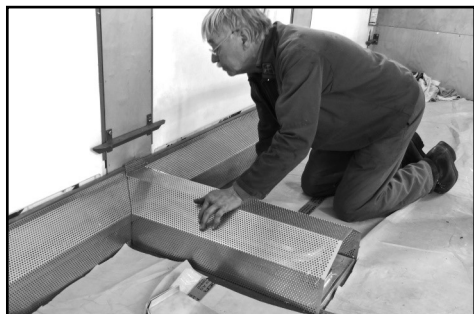
Abdeckung der Rohre mit Lochblechen
