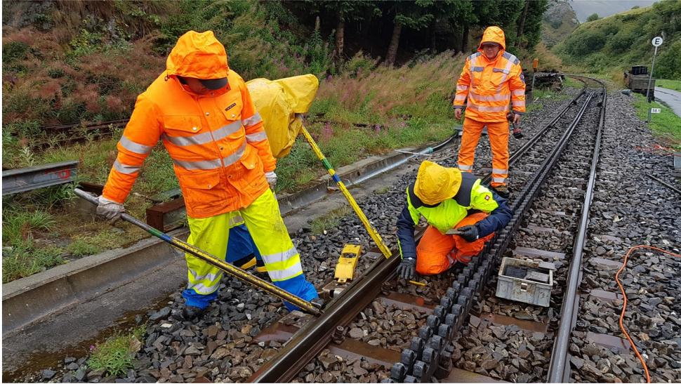
Hier wurde in den letzten Jahren (auch von uns) schon diverse Male durch Unterlegen von Platten bei der Schienen versucht, das Verhältnis richtig einzustellen, mit wechselndem Erfolg.
