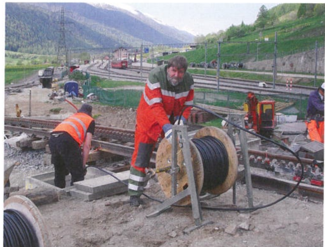
Einziehen der Kabel für die Sicherungsanlagen des Bahnüberganges Oberwald / Enfilage des câbles des installations de sécurité du passage à niveau Oberwald (Foto H. Unterweger)
