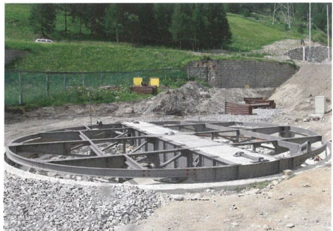
Die Stahlbaukonstruktion der Drehscheibe in Oberwald ist montiert La construction métallique de la plaque tournante à Oberwald est terminée
