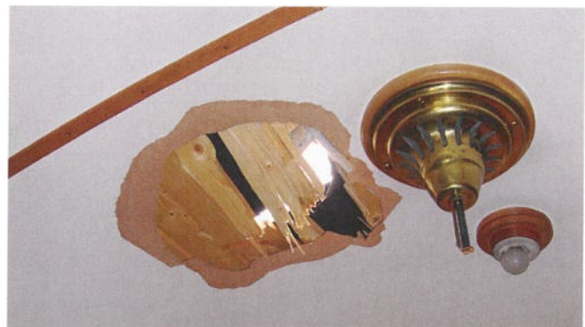
Steinschlagschaden am B 4453. Ein Felsbrocken hatte im Winterquartier in Göschenen mit grosser Wucht die Wagendecke durchschlagen.
