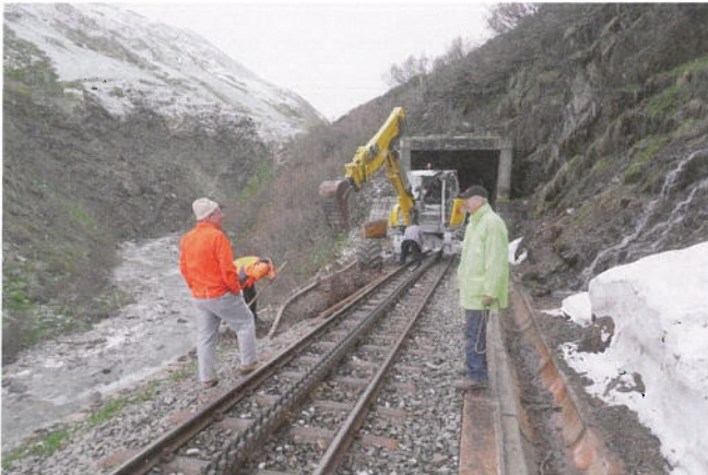
Der obere Teil der Stützmauer «bauchte» gegen die Furkareuss aus. Man hob gleisseitig Bodenmaterial aus und konnte so die Mauer wieder korrekt aufrichten. / La partie supérieure du mur de soutènement avait du fruit vers la Furkareuss. Le retrait de matériau du sol côté voie à permis de redresser le mur. (Foto: Edi Gubler)
