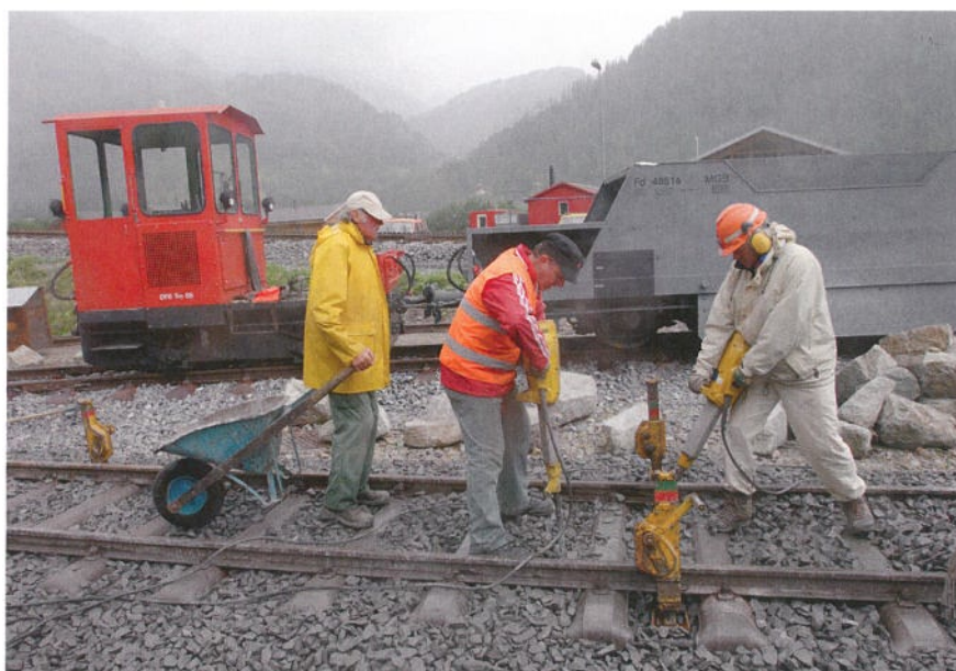
Einschottern und Gleis stopfen im Bahnhof Oberwald Ballastage et bourrage de la voie en gare d'Oberwald (Foto: C. Solioz)
