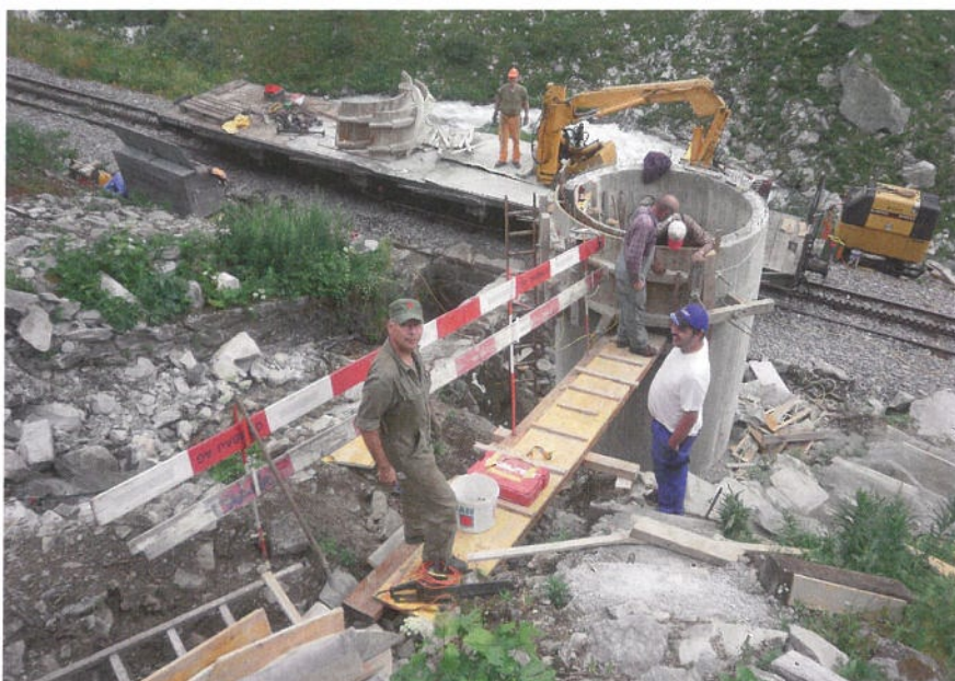
Weiterbau des Wasserreservoirs in der Rhoneschlucht für die Sprinkleranlage im Waldabschnitt / Poursuite de la construction du réservoir d'eau dans les gorges du Rhône pour l'installation d'arrosage dans la forêt (Foto: H. Deville)
