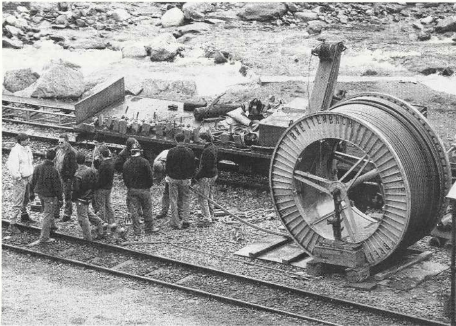
Frühmorgens erhält die Gruppe Instruktionen, wie das Zugseil mit der Elektroleitung zu verbinden ist.
