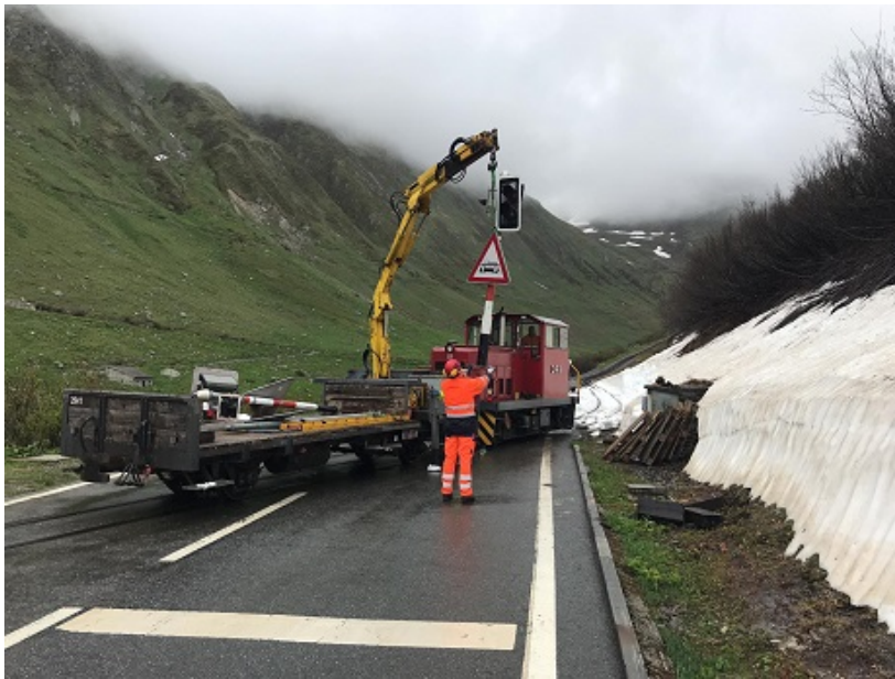
Montage des talseitigen Blinksignals des Bahnübergangs Furkastrasse.
