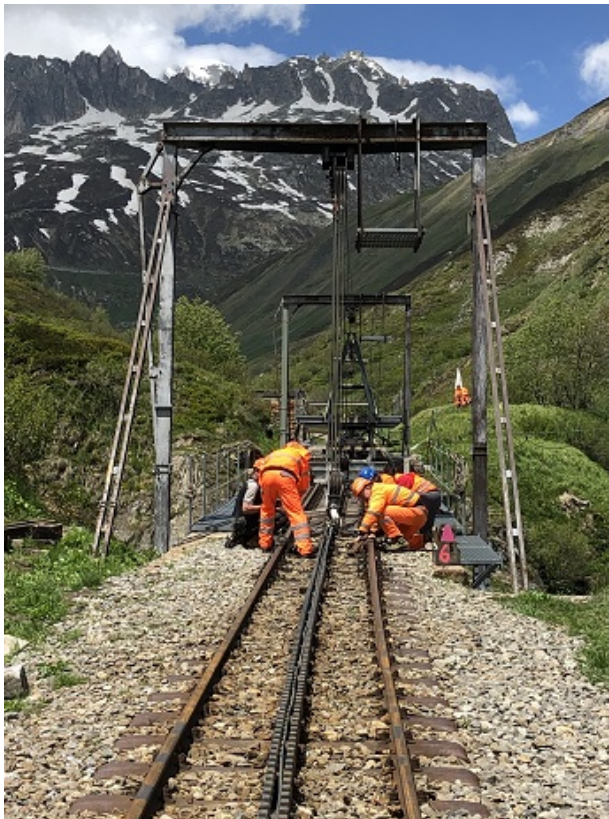
Montage der Laschen zwischen den Schienen des unteren Brückenelements und des unteren Widerlagers.
