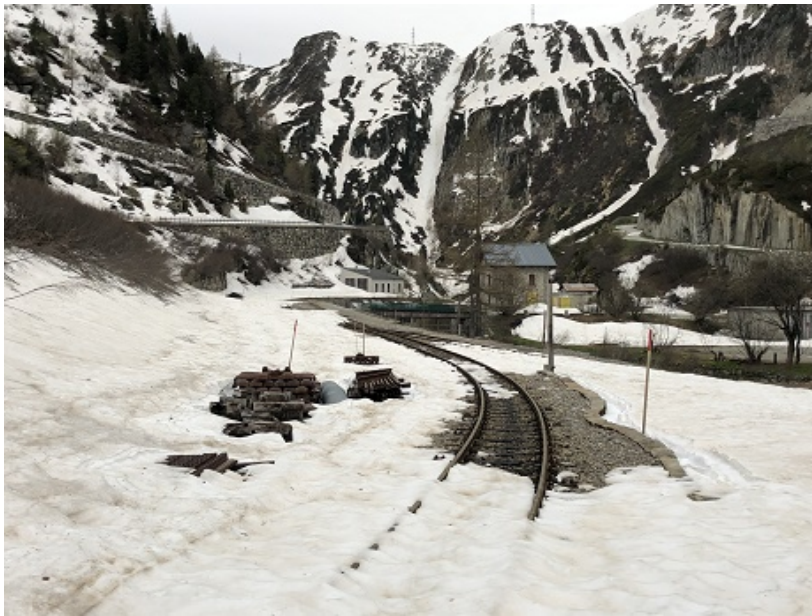
Bahnhof Gletsch vom Bahnübergang Blauhaus gesehen.
