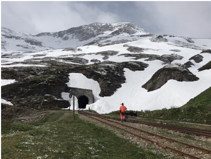
Das Ostportal des Scheiteltunnels.
