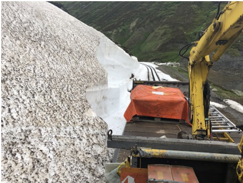
Auf der Fahrt zur Station Furka. Die Schneewächte kurz vor dem Steinstafelviadukt. Auf dem Kranwagen sind die Blachen des Festzelts geladen.
