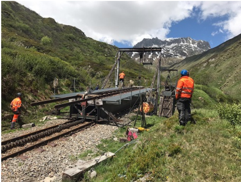
Das untere Brückenelement kurz vor der Verschiebung und Absenkung in die Sommerstellung.
