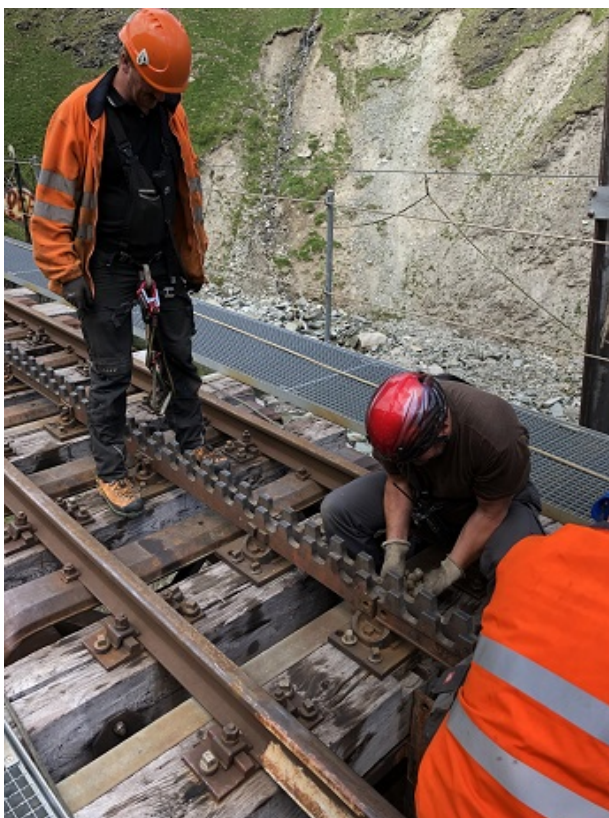
Adelbert Baggenstos verschraubt die Zahnstange beim Übergang vom Widerlager in das untere Brückenelement.
