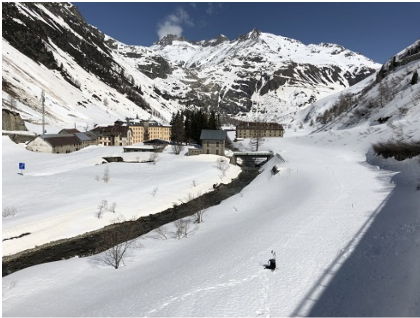
Im Areal des Bahnhof Gletsch liegt max. 2 m schlammiger Schnee.
