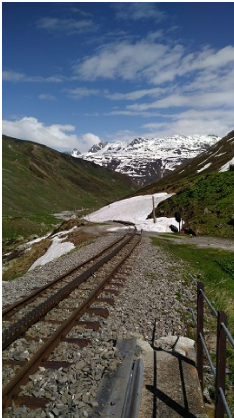
Blick vom Steinstaffelviadukt talwärts.
