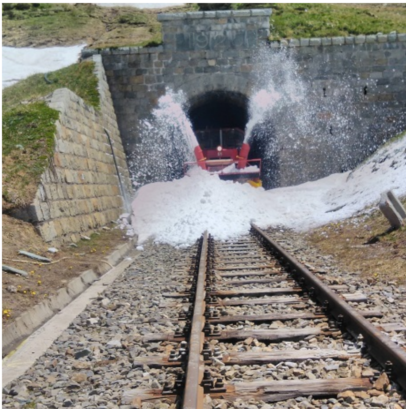
Die HGM 51 mit Anbaufräse am westlichen Portal des Scheiteltunnels.
