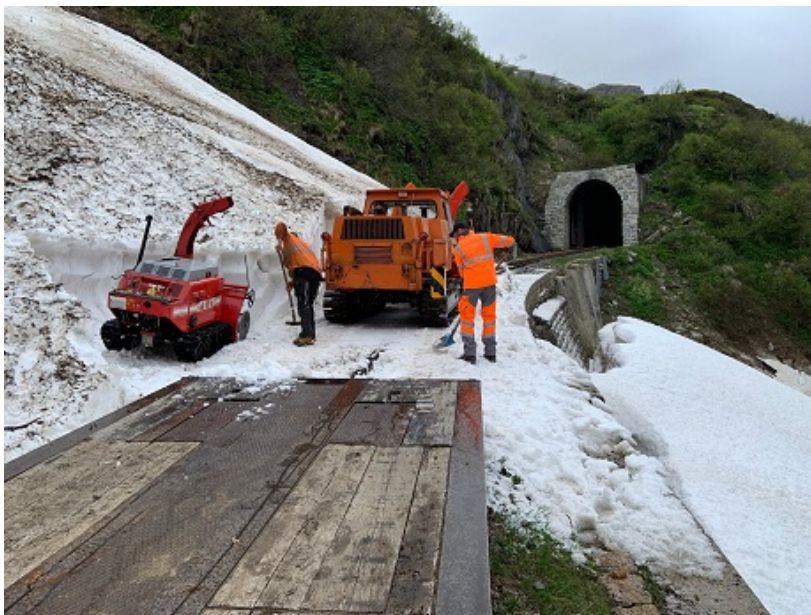
Als Schutzmassnahme schaufeln Stephan Stauber und Martin Wieland Schnee auf den Bahnkörper. Danach setzt die INTRAC Fräse zurück.
