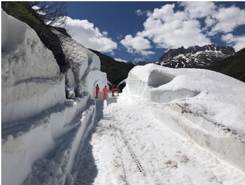
Der Schneekanal am frühen Nachmittag, welche die INTRAC Fräse seit dem frühen Morgen in den Lawinenkegel gefräst hat.
