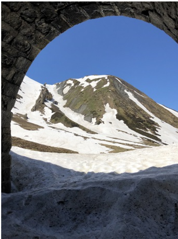
Blick aus dem Scheiteltunnel Seite Muttbach-Belvédère. Die Schneehöhe beträgt ca. 3 m.
