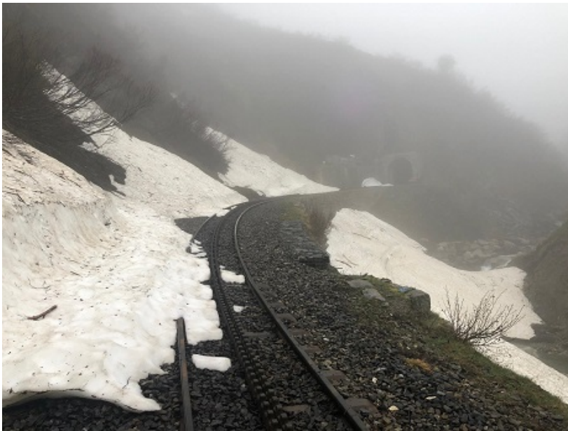
Der Rest der Lawinenkegel vor dem talseitigen Portal des Tunnels 3.
