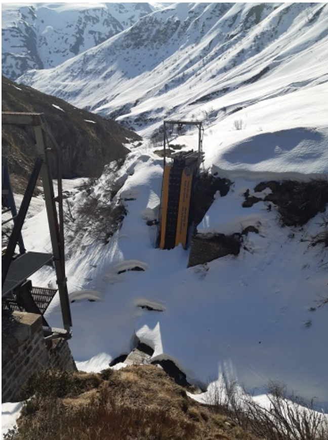
Blick vom bergseitigen Widerlager der Steffenbachbrücke.
