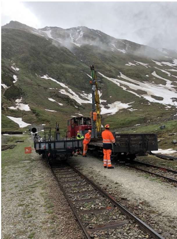
Umlad der Signale und Weichenböcke vom Tiefbord- auf den Kranwagen in der Station Muttbach-Belvédère.
