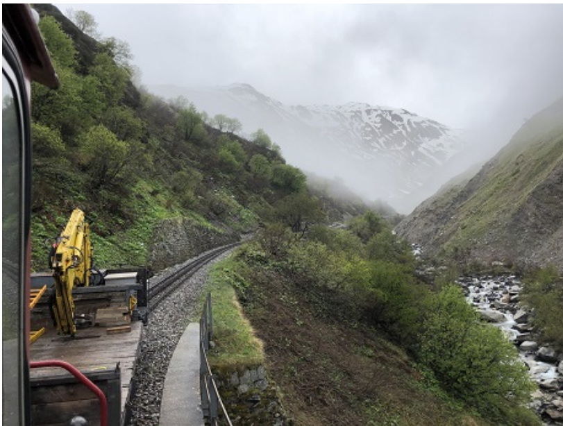
Bergfahrt mit dem Kranwagen für die Demontage der Stahlträger im bergseitigen Portal des Tunnels 3.
