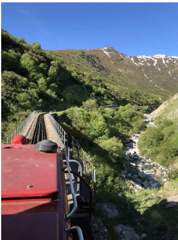
Die HGM 51 mit Tiefgänger kurz vor der Wilerbrücke.
