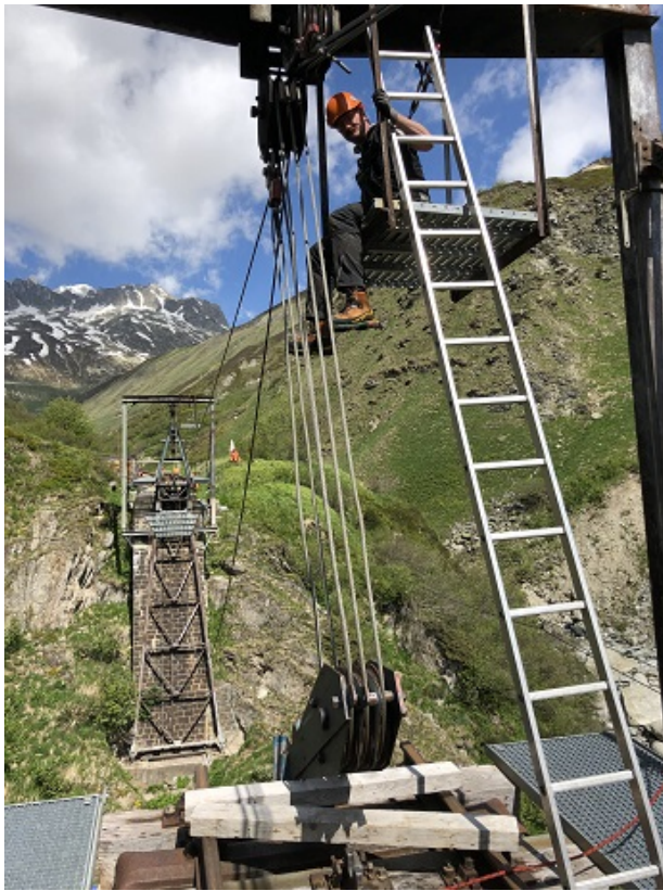
Stepahn Stauber flascht die Seilzüge in den unteren Umlenkrollen ein.
