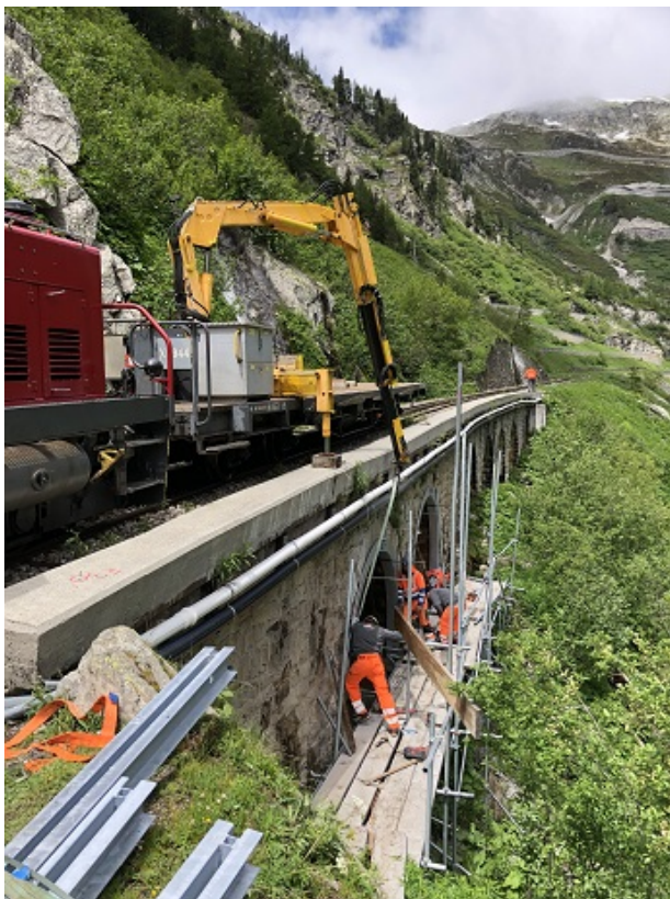
Das 2. Stahlbogenelement wird eingebracht.
