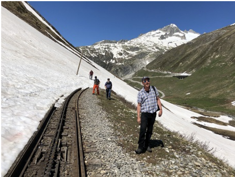
Blick von der Zahnstangeneinfahrt der Station Muttbach-Belvédère Richtung Bahnübergang Furkastrasse. Die ca. 2 m hohen Lawinenkegel würden derzeit noch den Einsatz einer INTRAC Fräse erfordern.
