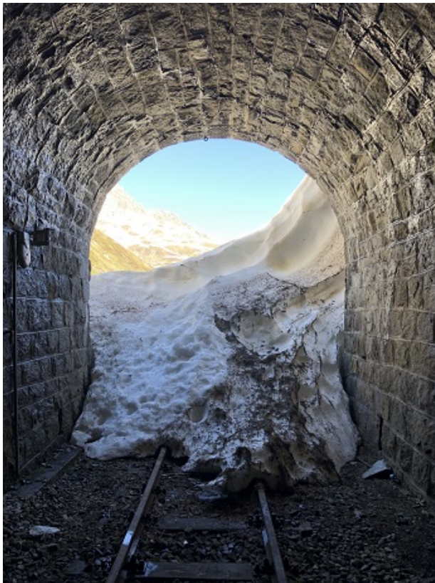
Blick aus dem Scheiteltunnel Seite Furka. Die Höhe des kurzen Lawinenkegels beträgt ca. 3 m.
