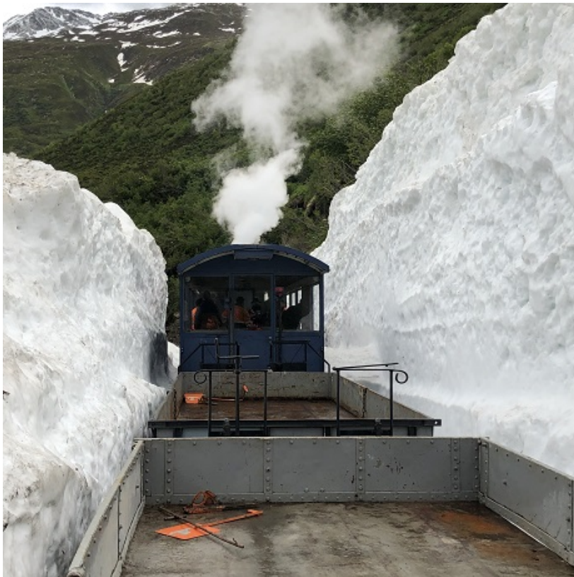
Der Überfuhrzug im Lawinenkegel zwischen Tunnel 1 und Tunnel 2.
