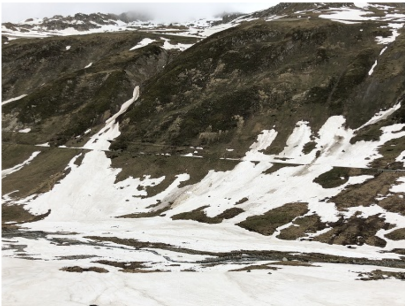
Die Zufahrtsstrasse zur Station Muttbach-Belvédère.
