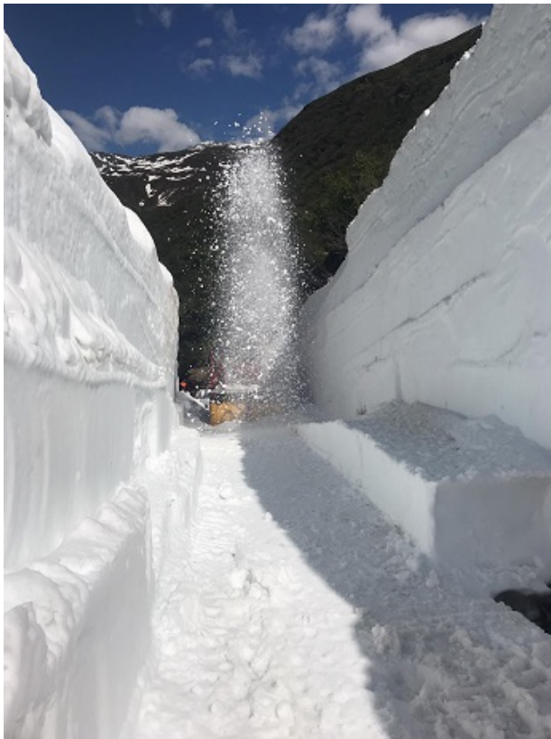
Die 4 bis 6 m hohen Schneewälle verunmöglichten das Auswerfen des gefrästen Schnees zur Seite.
