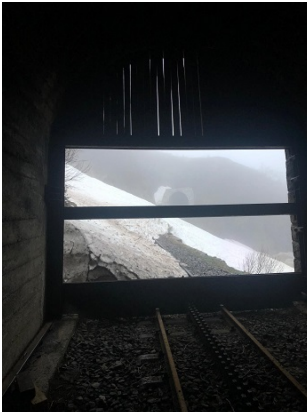
Das bergseitige Portal des Tunnels 3 mit den Stahlträgern.
