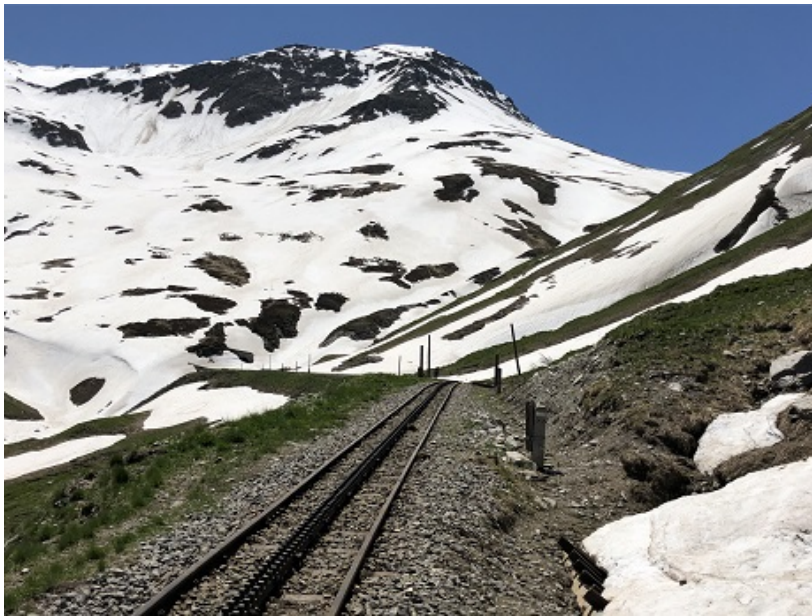
Blick von unterhalb der Zahnstangeneinfahrt Richtung Station Furka.
