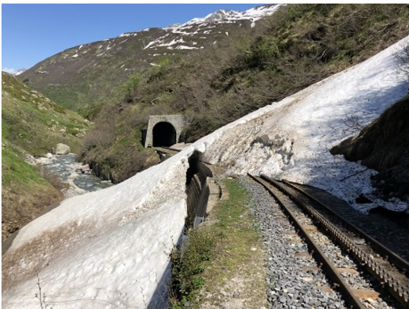
Blick vom bergseitigen Portal des Tunnels 2 auf den ca. 6 m hohen Lawinenkegel zwischen Tunnel 1 und Tunnel 2.
