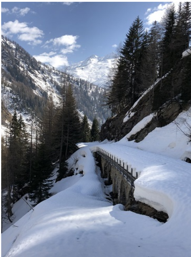
Das Lehnenviadukt Eischflüe bei km 43.9.
