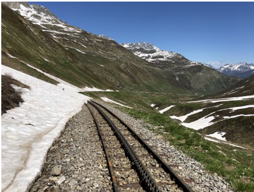
Blick von unterhalb der Zahnstangeneinfahrt der Station Furka talwärts. Die Lawinenkegel kurz vor der Station Furka können ohne Hilfe einer INTRAC Fräse mit der Anbaufräse der HGm 51 problemlos geräumt werden.
