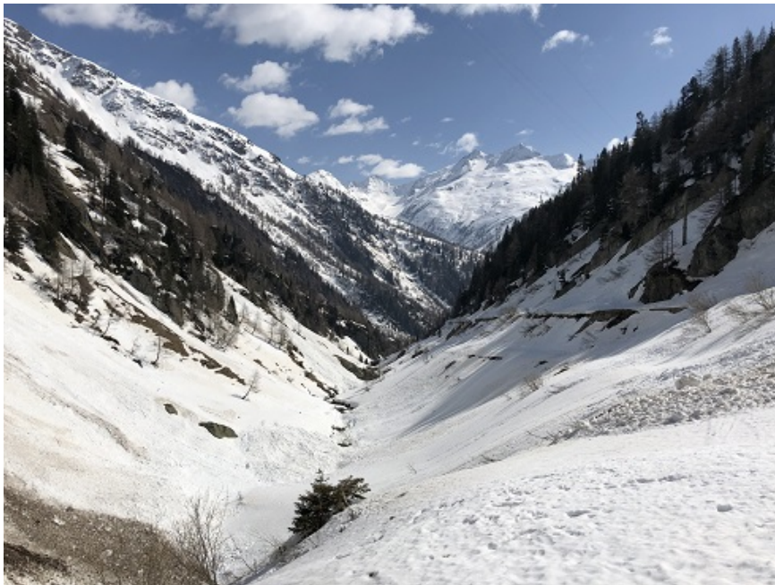
Blick von der Wasserfassung 2 in die Rottenschlucht. Am Horizont findet sich der 3060 m hohe Pizzo Gallina beim Nufenenpass. An exponierten Stellen liegt max. 4 m Schnee auf dem Bahnkörper.
