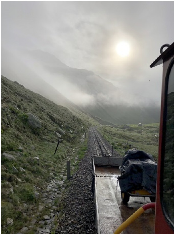
Morgenstimmung auf der Fahrt von Realp nach Oberwald. Auf dem Tiefbordwagen ist ein Stromaggregat geladen, das bei der Sanierung des Lehnenviadukts Mässweid benötigt wird.
