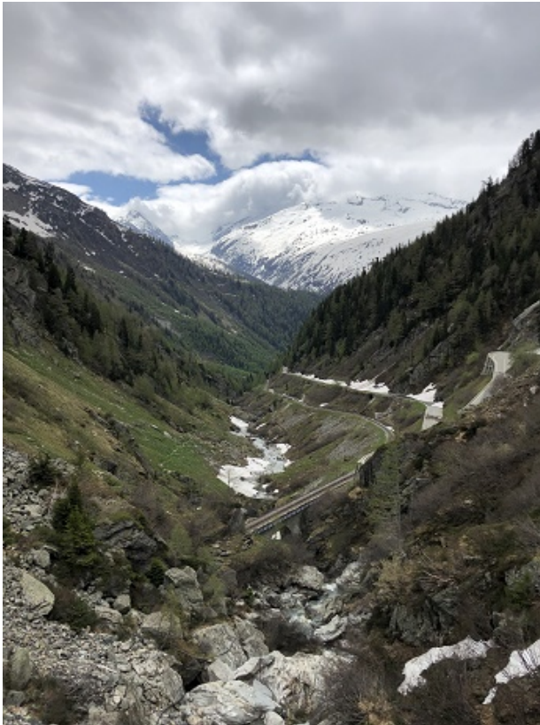
Blick von der Kantonsstrasse in die Rottenschlucht mit dem Rottenviadukt.
