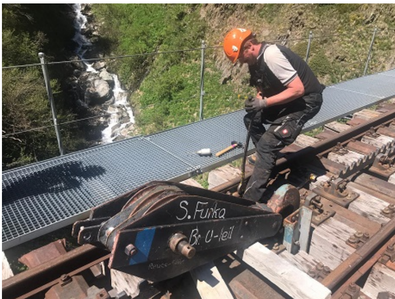
Stephan Stauber zieht die Muttern der Laschen zwischen dem unteren und mittleren Brückenelement an.
