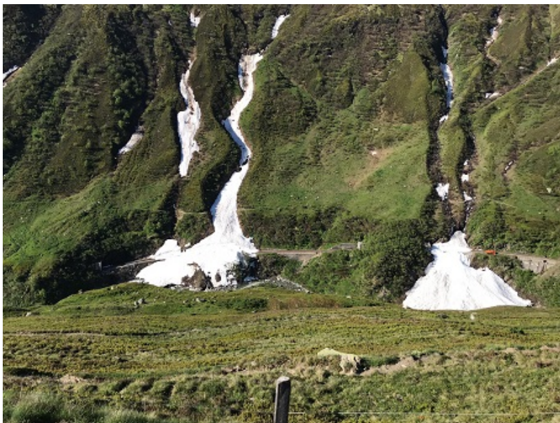
Blick von der Rufikehrstrasse auf die beiden Lawinenkegel oberhalb und unterhalb des Tunnels 1. Die INTRAC Fräse wartet oberhalb des Tunnels 1 auf ihren nächsten Einsatz beim Steinstafelviadukt.
