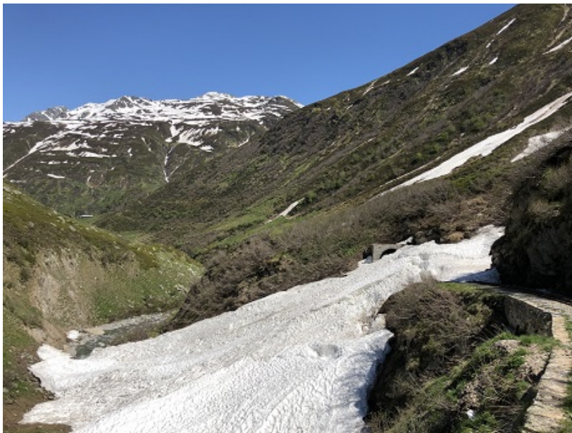
Der ca. 4 m hohe Lawinenkegel oberhalb des bergseitigen Portals des Tunnels 1.
