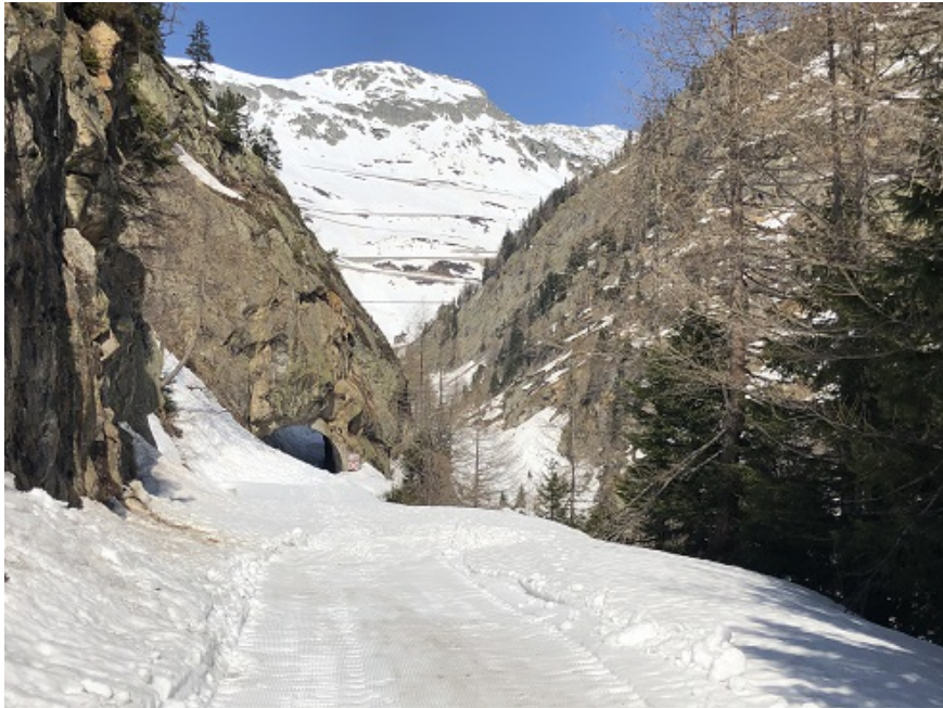
Der Strassentunnel am Eingang der Rottenschlucht.
