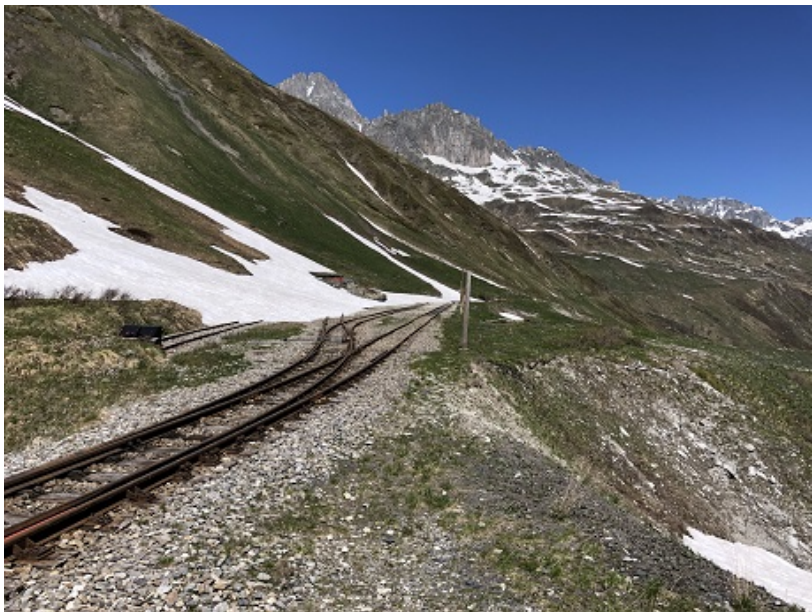
Station Furka mit der Einfahrweiche Seite Scheiteltunnel. Die Dachkanten der Station Furka sind bereits schneefrei.
