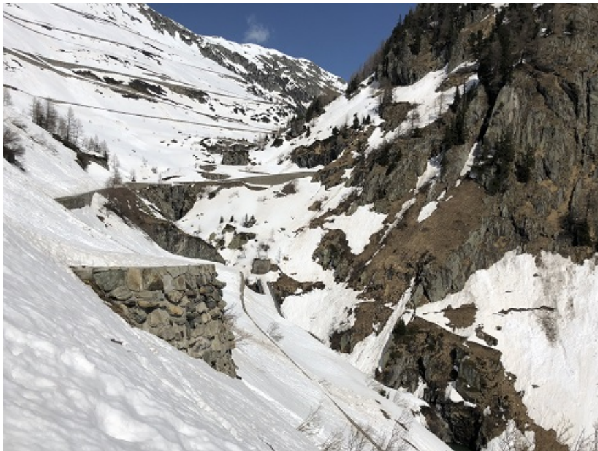
Das talseitige Tunnelportal des Kehrtunnels unterhalb von Gletsch.
