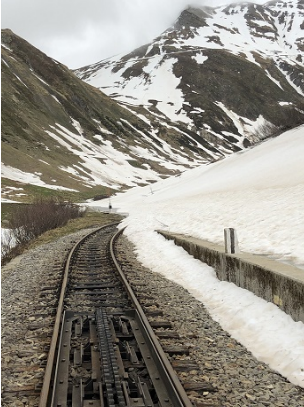
Zahnstangeneinfahrt unterhalb des Bahnübergangs Furkastrasse.
