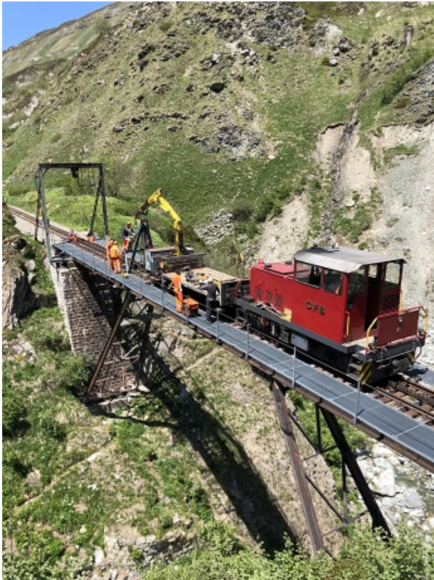
Demontage des Umlenkbockes und Abtransport der schweren Haken der Steffenbachbrücke. Gleichzeitig erneuern Fred Schöenthal und Andreas Simmen das verwitterte Tor des Windenhauses.
