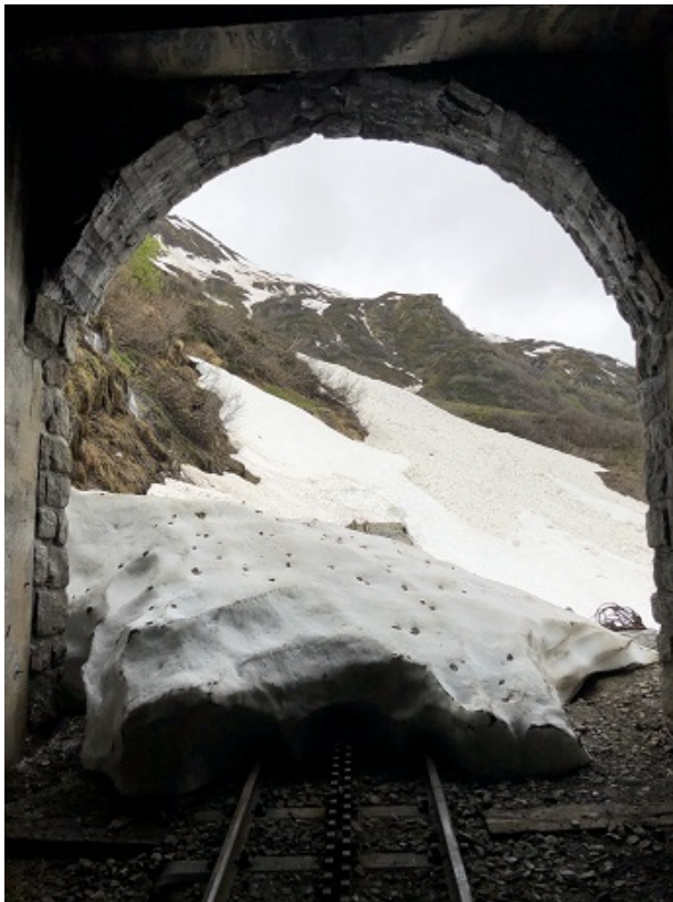
Blick aus dem bergseitigen Portal des Tunnels 2 auf den ca. 6 m hohen Lawinenkegel zwischen Tunnel 2 und Tunnel 1.
