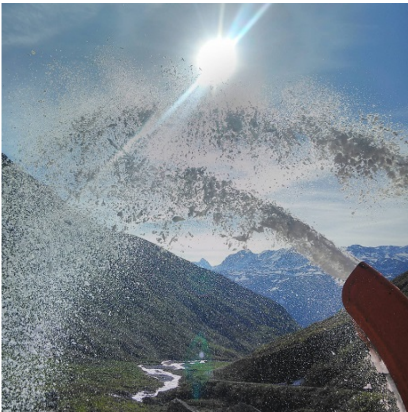
Die INTRAC Fräse im Einsatz unterhalb des Steinstafelviadukts.
