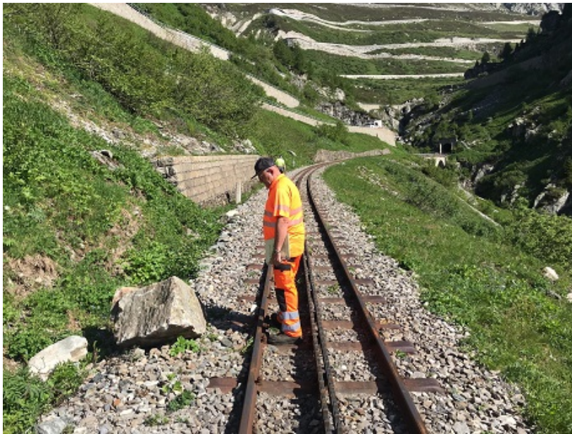
Felsbrocken unterhalb des Rottenviadukts.
