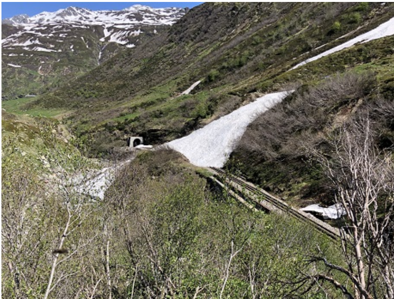
Blick von der Felsnase des Tunnels 1 talwärts Richtung Tunnel 2.
