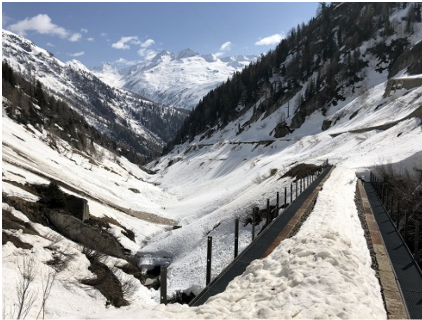
Die Rottenbrücke bei km 44.9.
