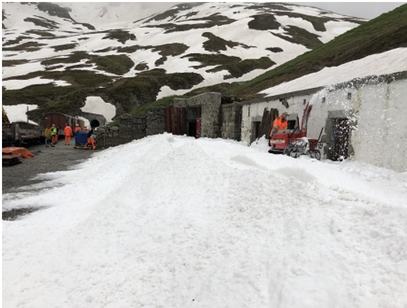
Nach 5 Stunden unermüdlichem Fräsen konnte mit der YANMAR Fräse nur ca. einen halben Meter Schnee abgetragen werden. Der verbliebene Schnee vor dem Stationsgebäude wurde daher der Sonne überlassen.
