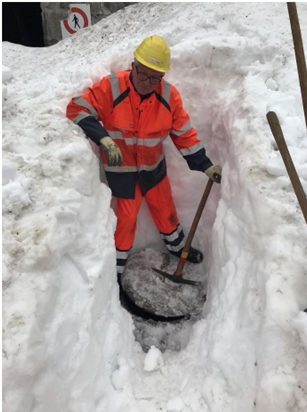
Werner Dietrich hat den Schacht für die Wasserversorgung der Station Furka ausgegraben.
