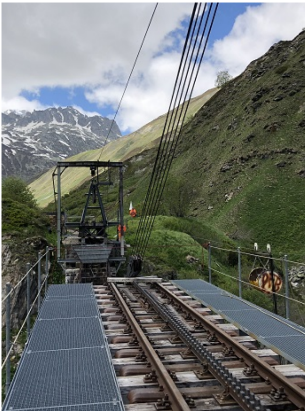
Langsam wird das untere Brückenelement in die Sommerstellung geschoben und abgesenkt.
