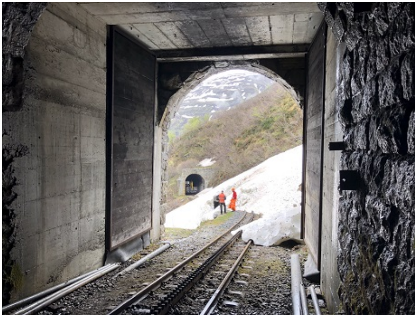
Blick aus dem talseitigen Portal des Tunnels 2 Richtung Tunnel 3. Im Tunnel 2 wurden keine Vereisungen gefunden.
