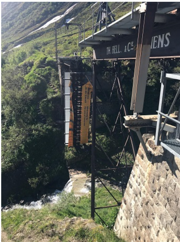
Der Seilzug ist im mittleren Brückenelement montiert. Nun wird das mittlere Brückenelement langsam hochgezogen.
