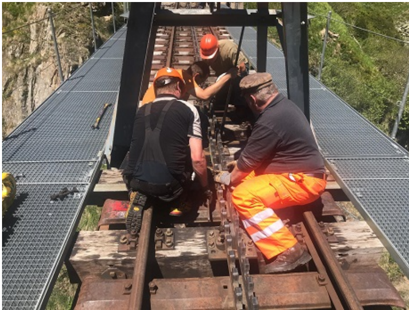
Montage der Laschen zwischen dem mittleren und oberen Brückenelement.
