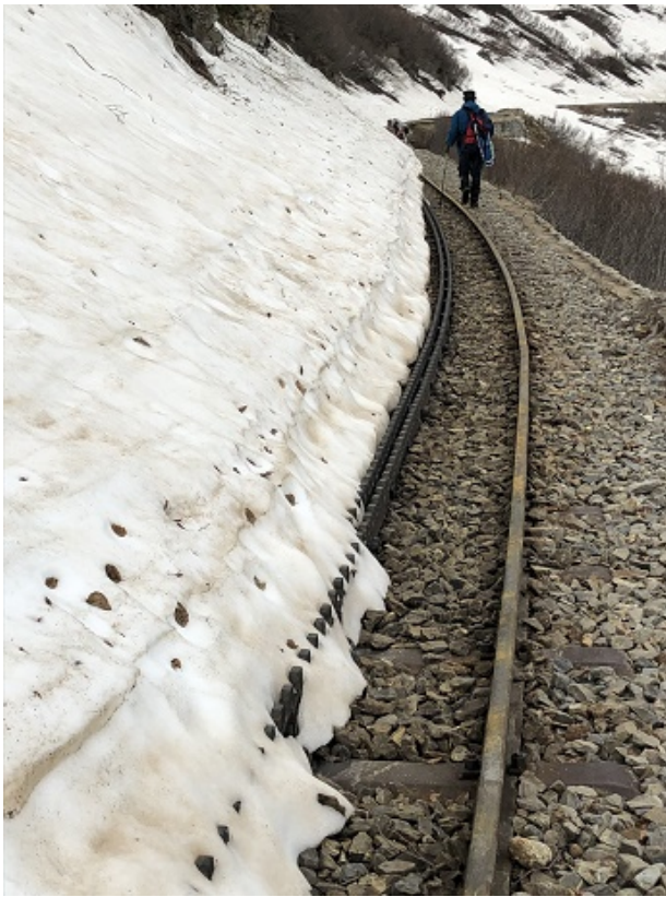
Bahntrasse bei der Hilfsbrücke zwischen Bahnhof Gletsch und Bahnübergang Furkastrasse.
