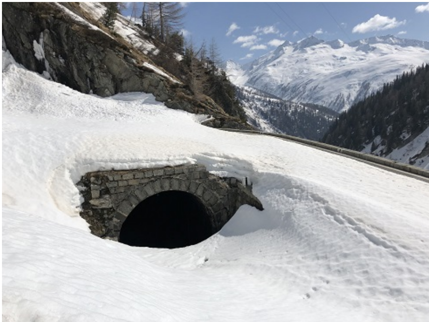
Das bergseitige Tunnelportal des Kehrtunnels unterhalb von Gletsch.
