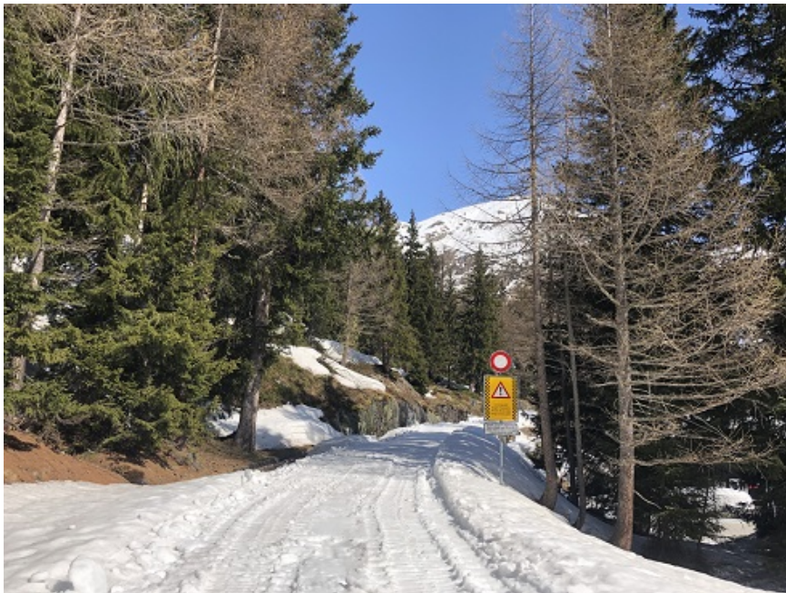
Bis zum Restaurant Rhonequelle ist die Kantonsstrasse bereits geräumt. Auf der Kantonsstrasse zwischen Rhonequelle und Strassentunnel liegt max. 1.5 m Schnee.
