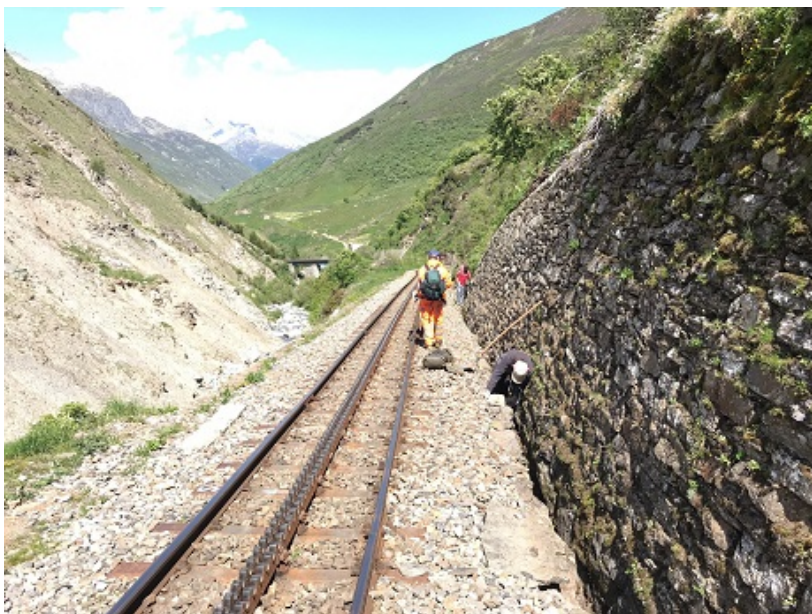
Putzen der Wassergräben zwischen Tunnel 3 und der Wilerbrücke.
