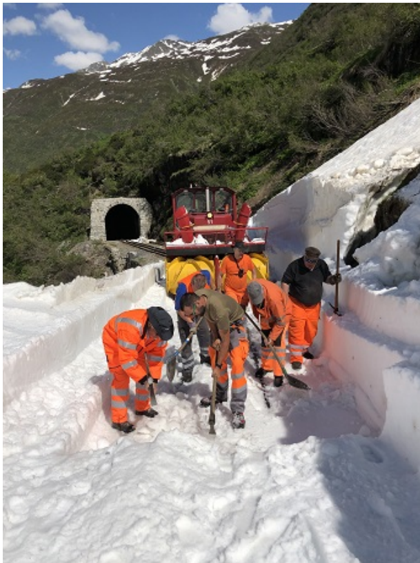
Mit vereinten Kräften wird das Eis von den Schienen und Zahnstange gepickelt.
