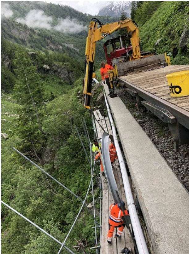
Das 1. Stahlbogenelement wird eingebracht.
