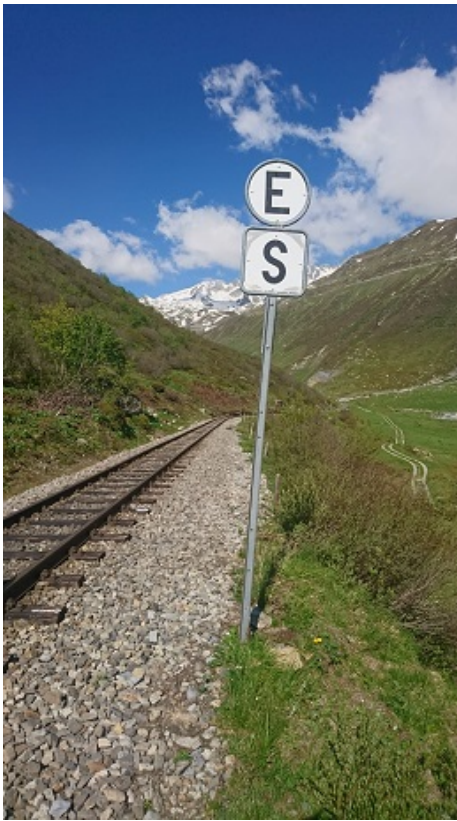
Bei der talseitigen Zahnstangeneinfahrt der Station Tiefenabch.
