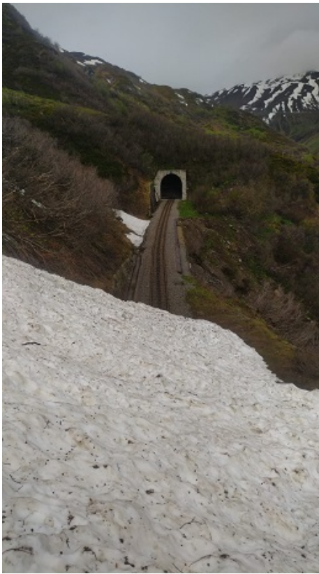
Blick vom ca. 6 m hohen Schneekegel zum talseitigen Portal des Tunnels 1.
