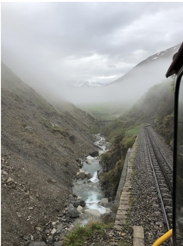
Morgenstimmung oberhalb der Wilerbrücke während der Fräsfahrt zum Tunnel 3.
