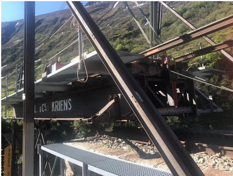
Langsam wird das obere Brückenelement in die Sommerstellung verschoben und abgesenkt.
