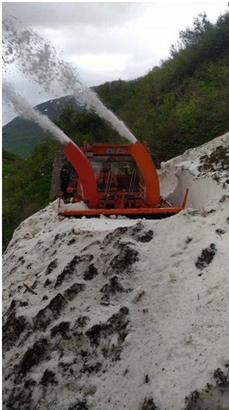
Martin Wieland fräst sich durch den 2 m hohen Lawinenkegel zwischen Tunnel 3 und Tunnel 2.
