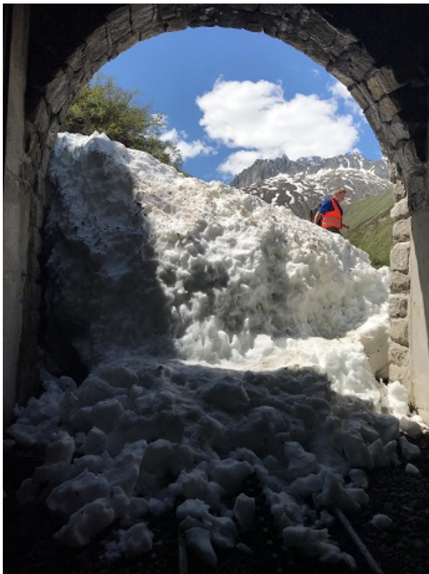
Mit Schaufel und Pickel hat Stephan Stauber beim bergseitigen Portal des Tunnels 1 eine Auffahrt für die INTRAC Fräse und einen bequemen Fussweg konstruiert.
