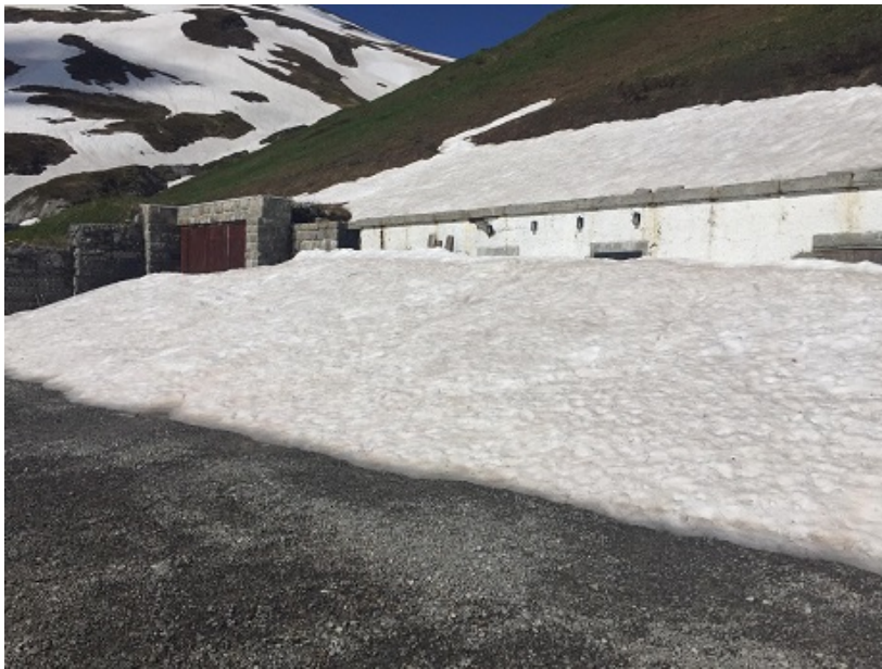
Das Stationsgebäude der Station Furka.
