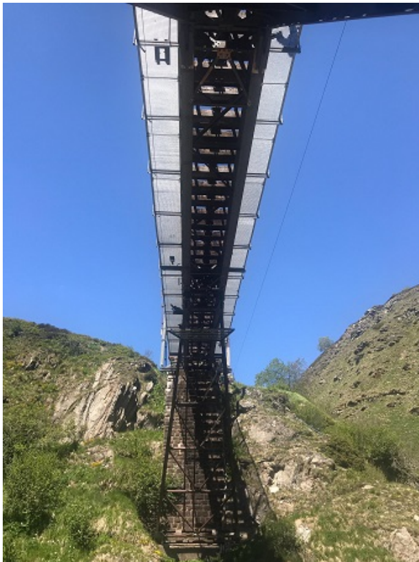
Blick vom unteren Widerlager zur Steffenbachbrücke.
