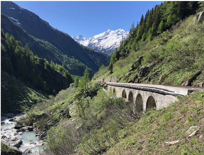
Das Lehnenviadukt Massweid.
