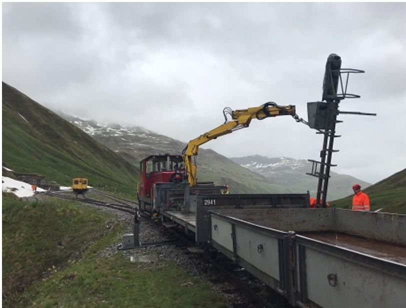
Montage des Ausfahrtsignals der Station Furka.
