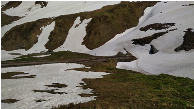
Das Tunnelportal des Scheiteltunnels und die Einfahrweiche der Station Furka.
