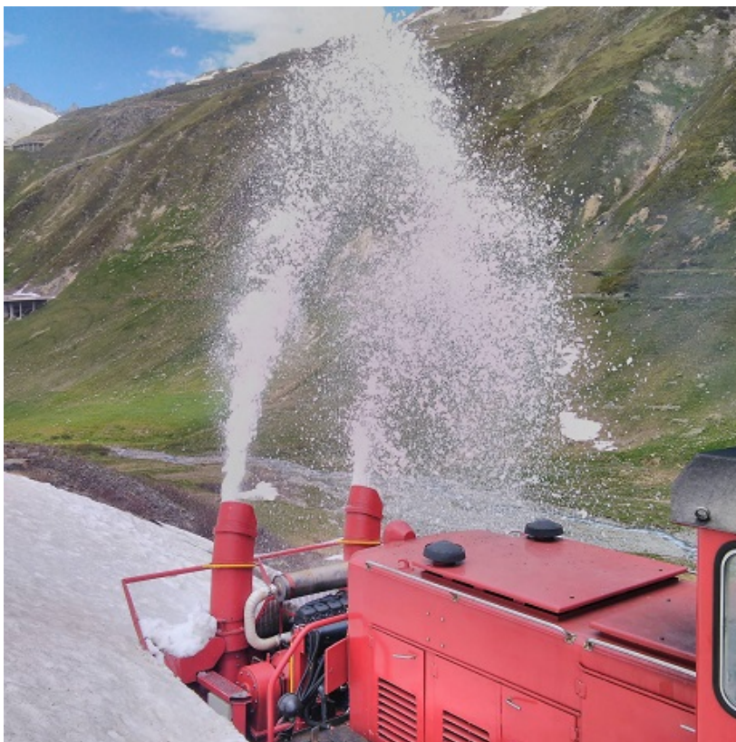
Langsam fräst sich die HGM 51 mit Anbaufräse von der Station Muttbach-Belvédère zum Bahnübergang Furkastrasse hinunter.
