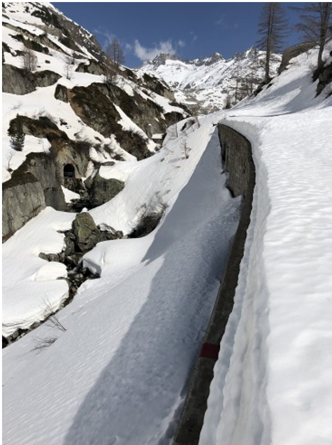
Das Lehnenviadukt Biel bei km 45.7.
