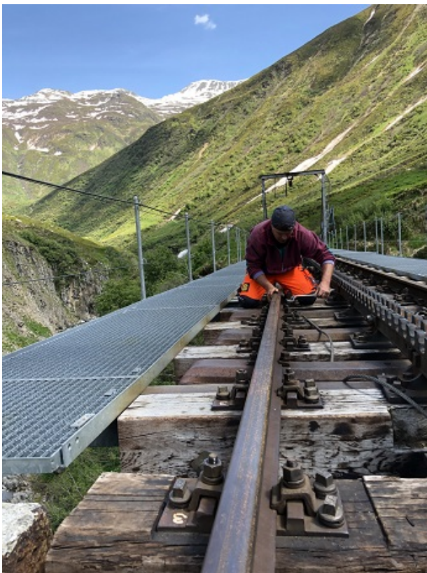
Marcel Schild montiert die letzten Schrauben der Steffenbachbrücke.
