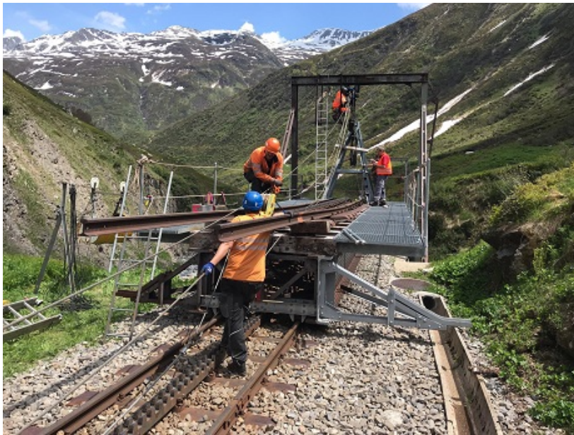
Einflaschen der Seilzüge im oberen Brückenelement.
