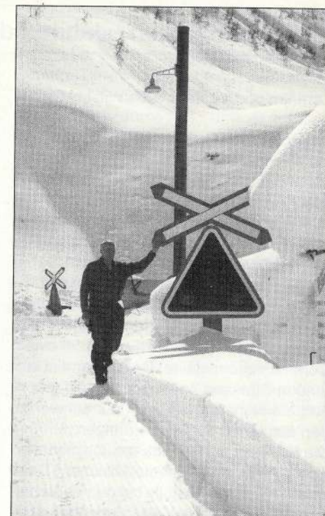
Strassenübergang beim Depot Realp, Schweigstrasse. Der Jahrhundertschnee hinterlässt Spuren ...
