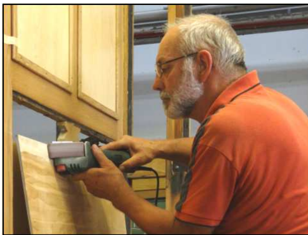
Sorgfältige Einpassung der Wandplatten aus Birkenperrholz
