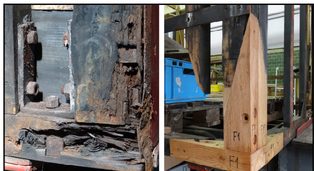
Eine Wagenecke vor und nach der Reparatur
