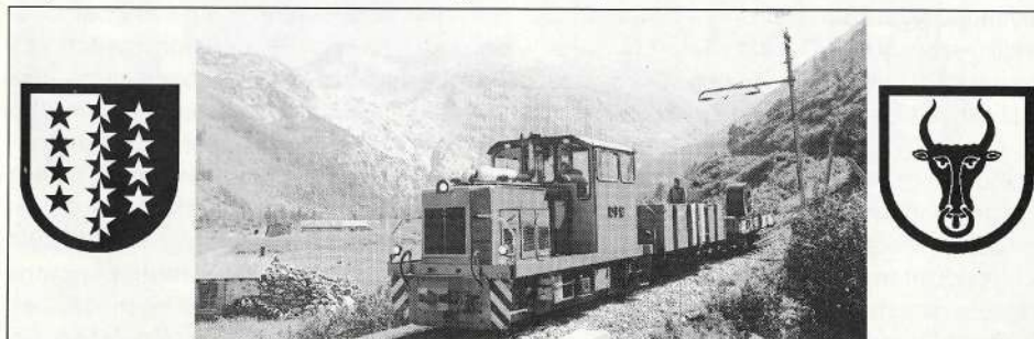
Erster offizieller Bauzug in Gletsch 30.7.98; im Hintergrund Rohnegletscher Foto: DFB
