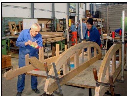
Zusammenbau der Dachbögen im Türbereich
